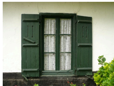
Vue détaillée d'un contrevent. Phot. Inès Guérin IVR22_20078005820NUCA
