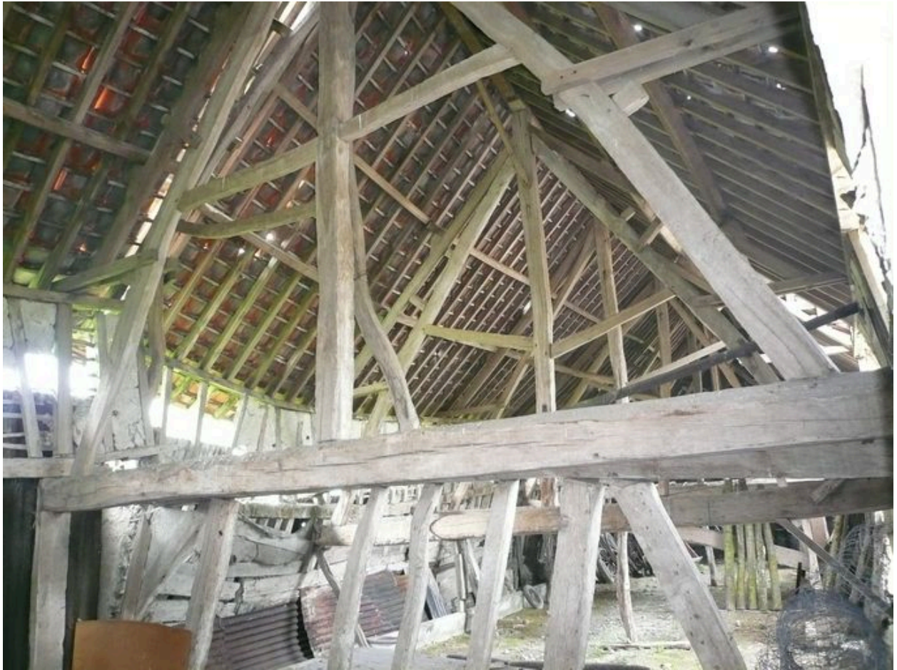
Vue intérieure de la partie grange.
