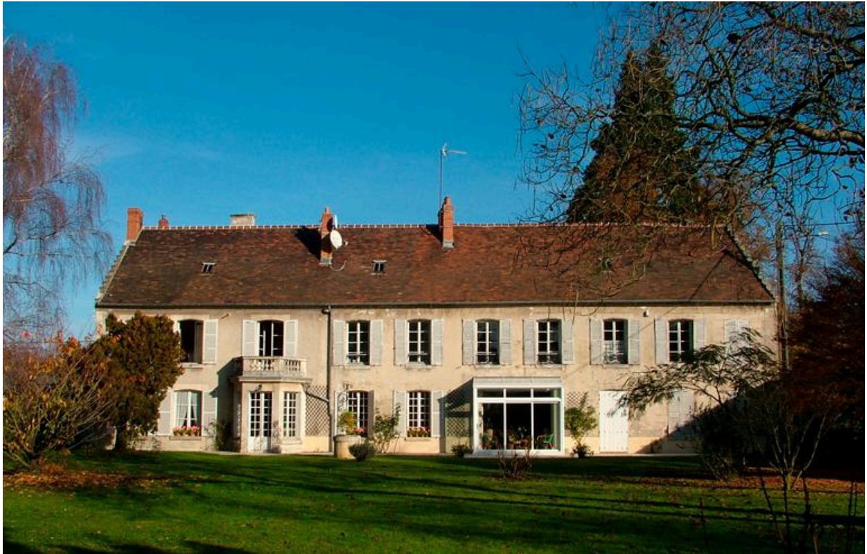
Vue du "fief d'Abonval", dépendance de l'ancien château.
