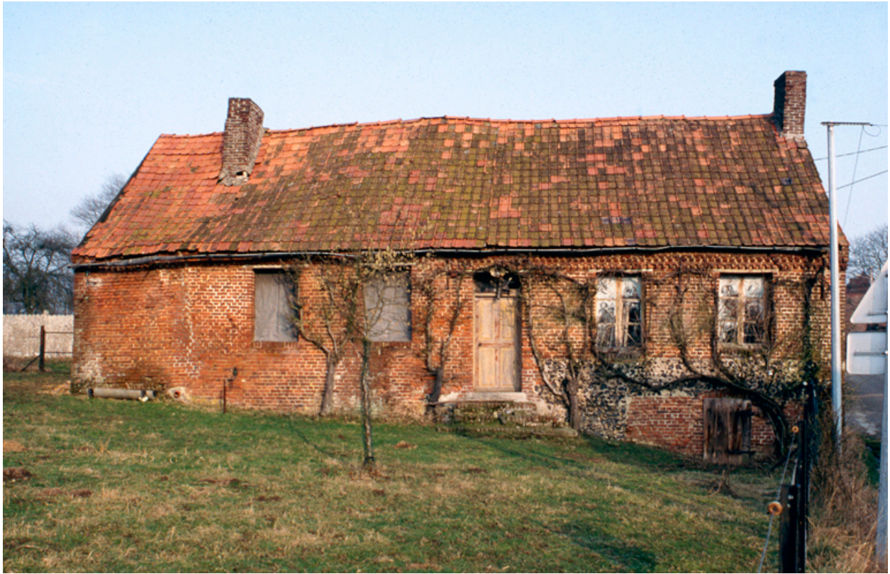
Vue d'ensemble de la façade.
