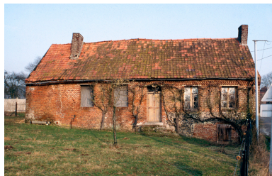
Vue d'ensemble de la façade. Phot. Christiane Riboulleau IVR22_19910202707ZA
