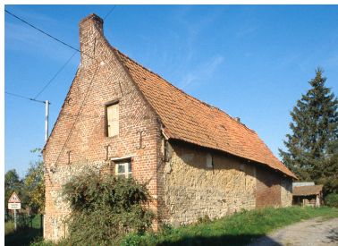
Vue d'ensemble depuis l'est. Phot. Martine Plouvier IVR22_19900202812ZA
