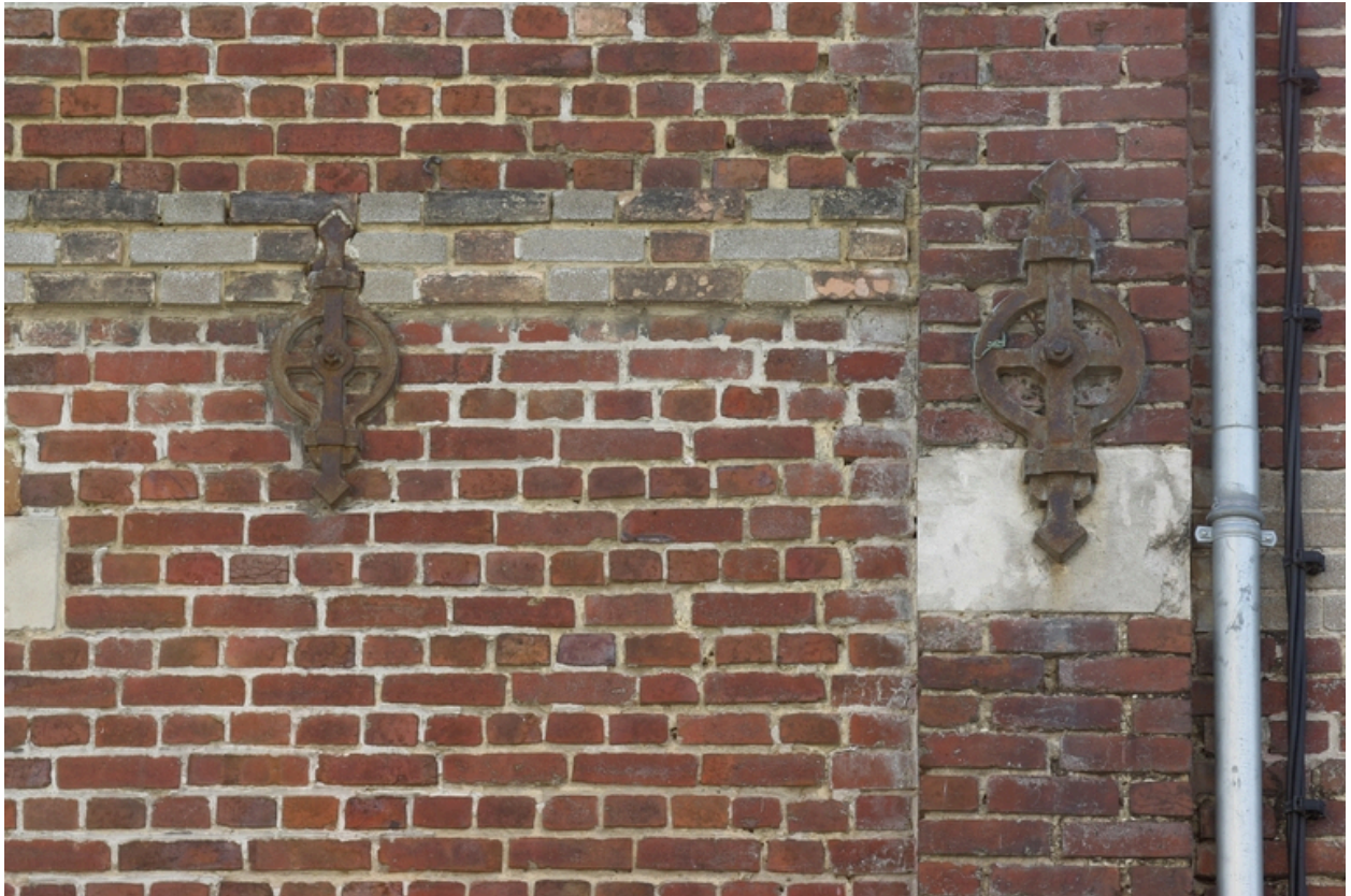
Détail des maçonneries des bureaux (à gauche) et des ateliers (à droite), rue des Islots.
