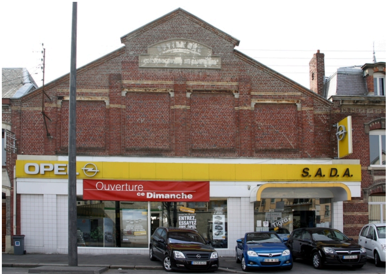
Façade antérieure des ateliers.
