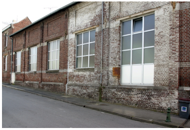
Façade des ateliers, rue des Islots. Phot. Frédéric Pillet IVR22_20050205341NUCA
