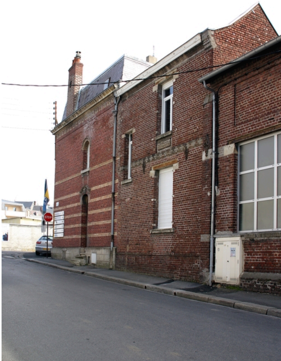
Logement patronal et bureaux, rue des Islots.
