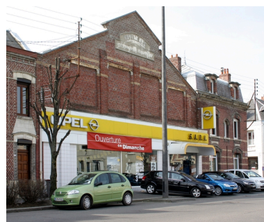
Façades antérieures des ateliers et du logement patronal, boulevard Victor-Hugo. Phot. Frédéric Pillet IVR22_20050205338NUCA
