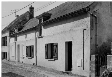
Vue de la façade. Phot. Christiane Riboulleau IVR22_19880201215X
