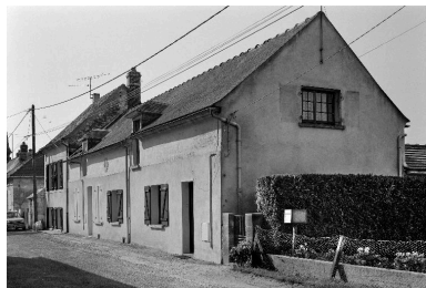
Vue générale de la maison. Phot. Christiane Riboulleau IVR22_19880201216X
