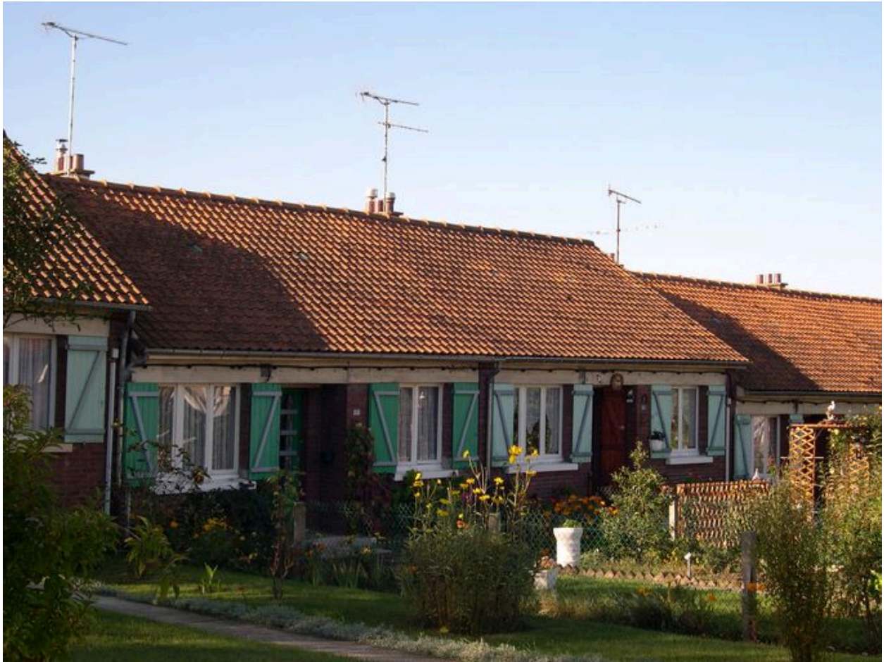
Vue d'une maison du lotissement, 136 et 138 rue Henri-Barbusse.
