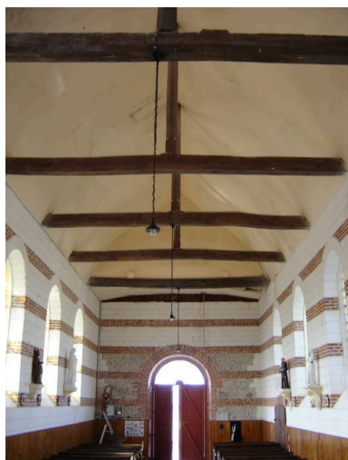
Vue intérieure de la nef. Phot. Inès Guérin IVR22_20078005974NUCA
