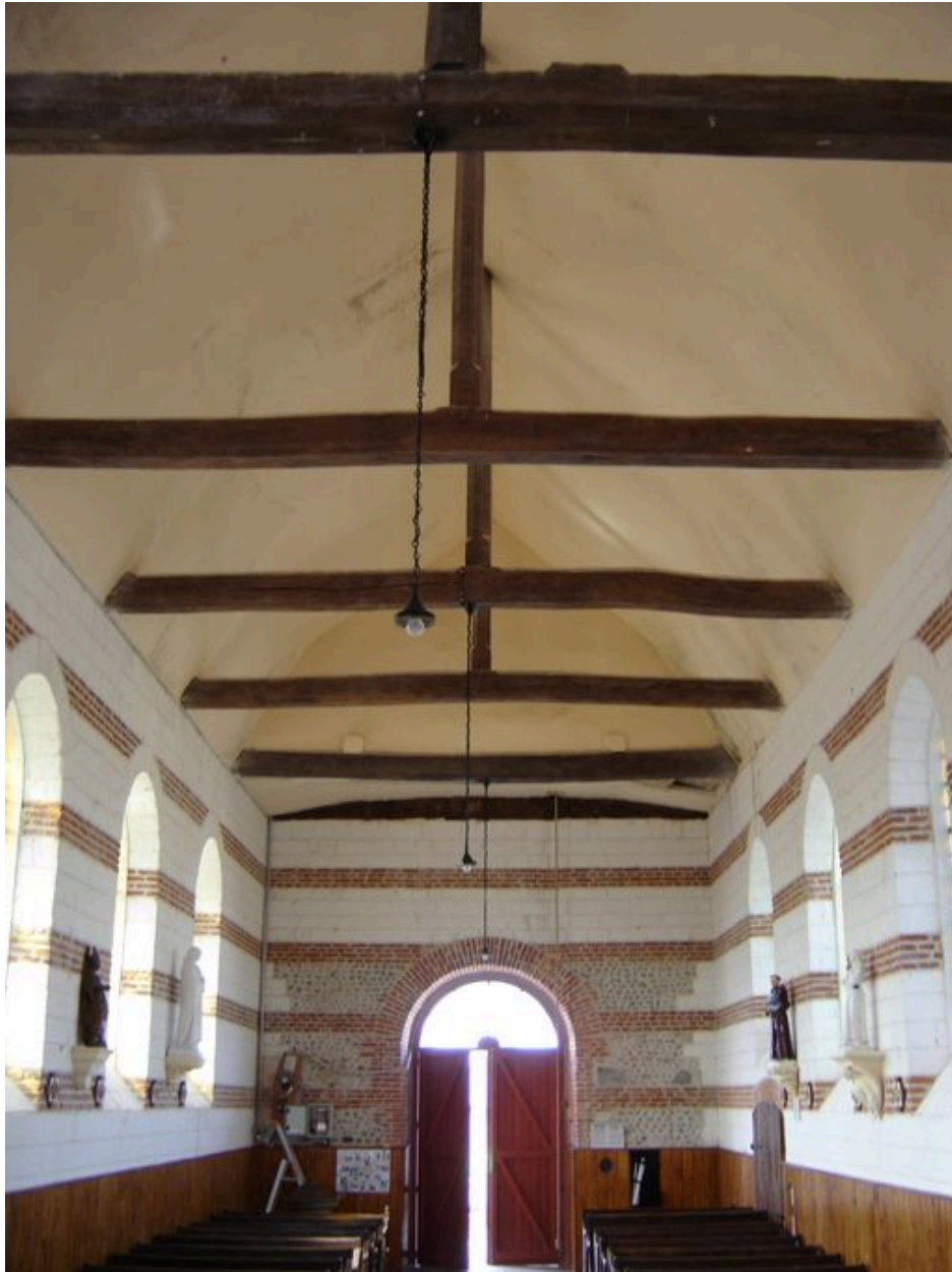
Vue intérieure de la nef.
