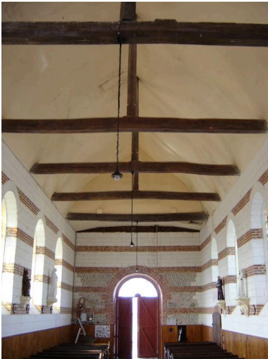
Vue intérieure de la nef.
