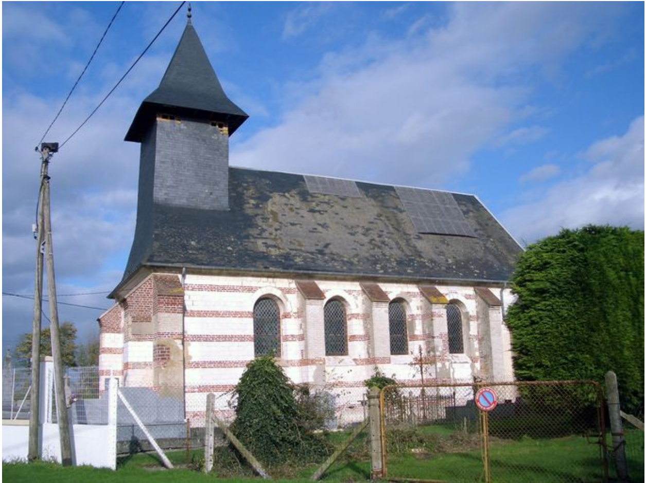
Vue depuis le sud.
