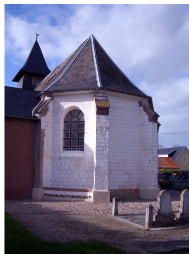
Vue du chevet. Phot. Inès Guérin IVR22_20078005973NUCA
