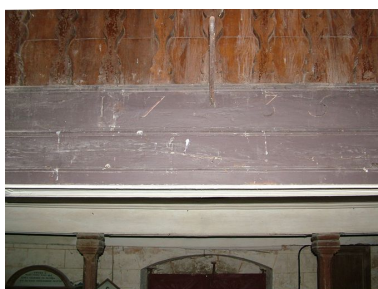
Vue de la poutre extérieure portant la date de 1733. Phot. Frédéric Fournis IVR22_20098005343NUCA
