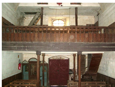
Vue générale. Phot. Frédéric Fournis IVR22_20098005342NUCA
