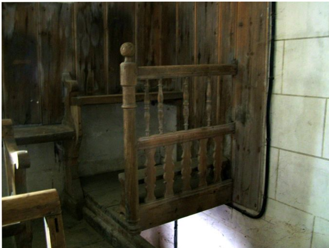
Petite tribune surplombant l'escalier.
