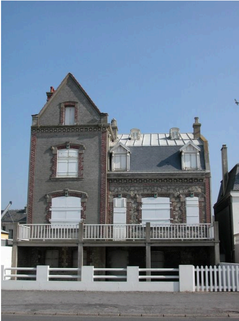
Vue d'ensemble, élévation côté mer.
