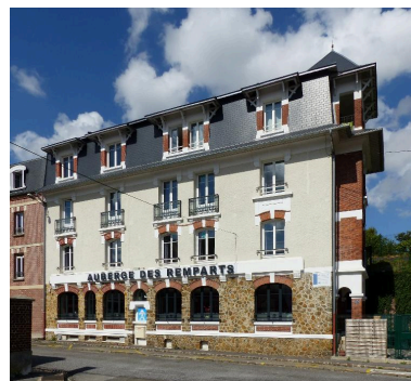
Vue de la façade sur rue. Phot. Isabelle Barbedor IVR32_20178005230NUCA
