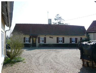
Vue du logis. Phot. Inès Guérin IVR22_20078005502NUCA
