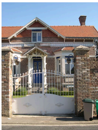
Vue de situation. Phot. Isabelle Barbedor IVR22_20038010744NUCA
