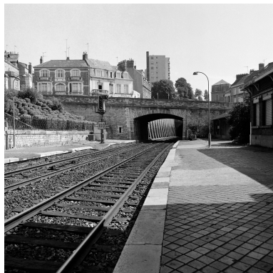
Vue générale du quai de la gare Boulogne-Tintelleries. Phot. Philippe Dapvril IVR31_19896200719X
