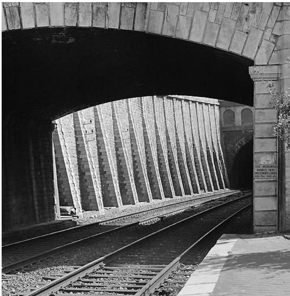
Elévation côté gare, détail.
