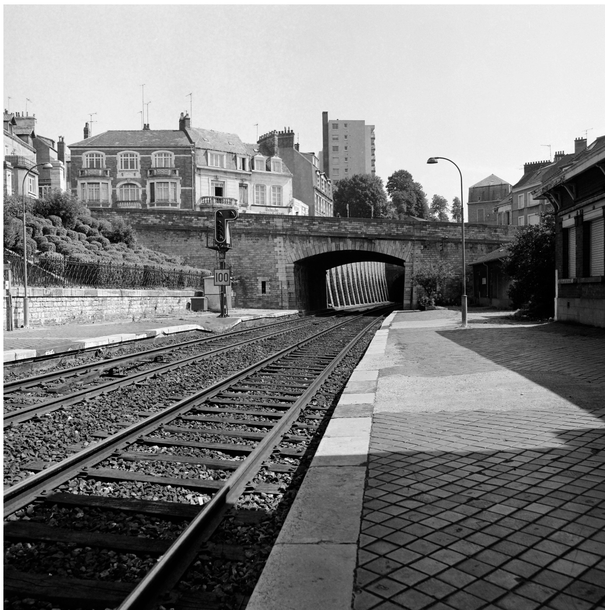
Vue générale du quai de la gare Boulogne-Tintelleries.
