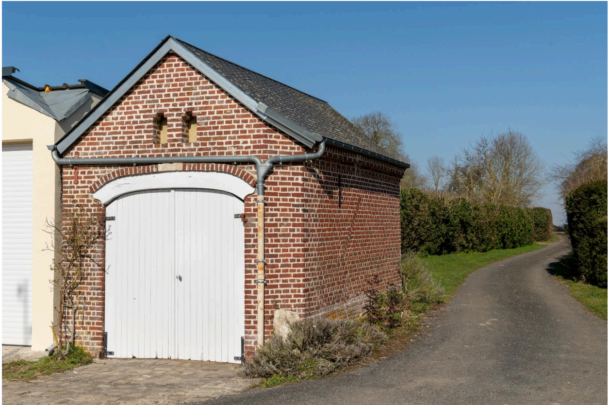
Bâtiment des pompes de la Neuve-Rue.
