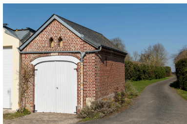
Bâtiment des pompes de la Neuve-Rue. Phot. Marc Kérignard IVR32_20236000173NUCA
