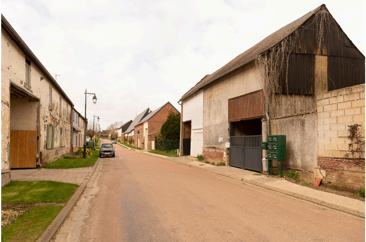
La Neuve-Rue, vue générale vers l'ouest.
