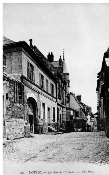
Elévation sur rue, avant 1914 (AP). Phot. Jean-Michel Périn IVR22_19856000122XB
