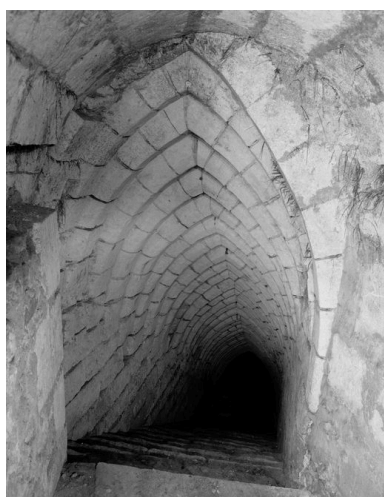
Escalier communiquant avec le sous-sol de la chapelle. Phot. Fabrice Charrondière IVR22_19856001546V
