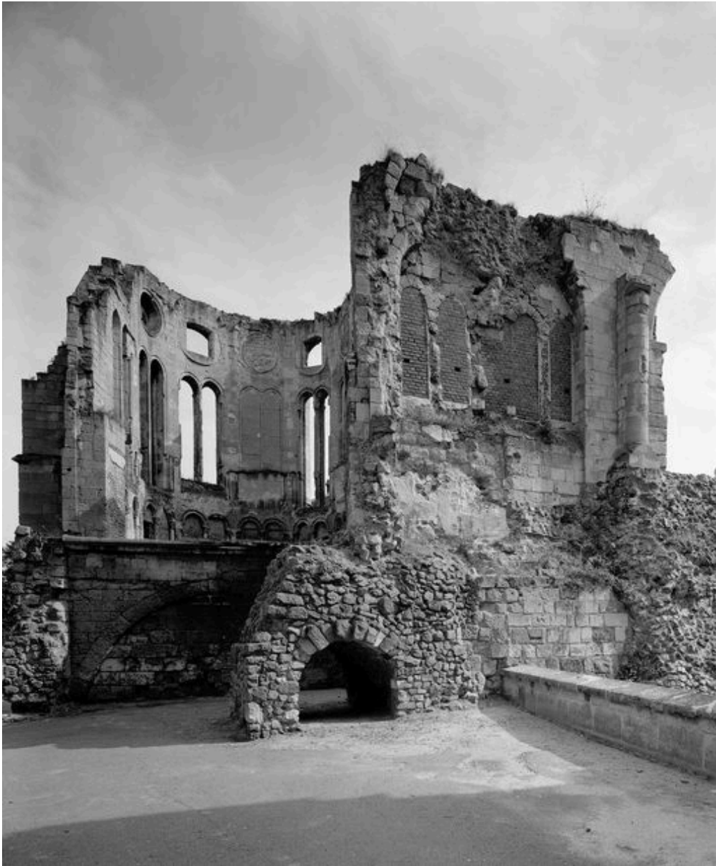
Vue d'ouest en est. Mur gallo-romain et vestiges de l'évêché du 12e siècle, intérieur de la chapelle.
