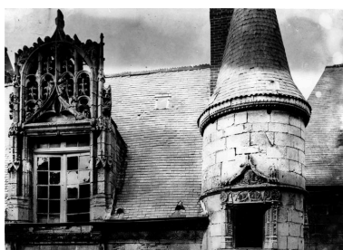
Détail de la tourelle d'angle et d'une lucarne, avant 1914 (AP). Repro. Monnehay-Vulliet Marie-Laure IVR22_20096000453NUCA
