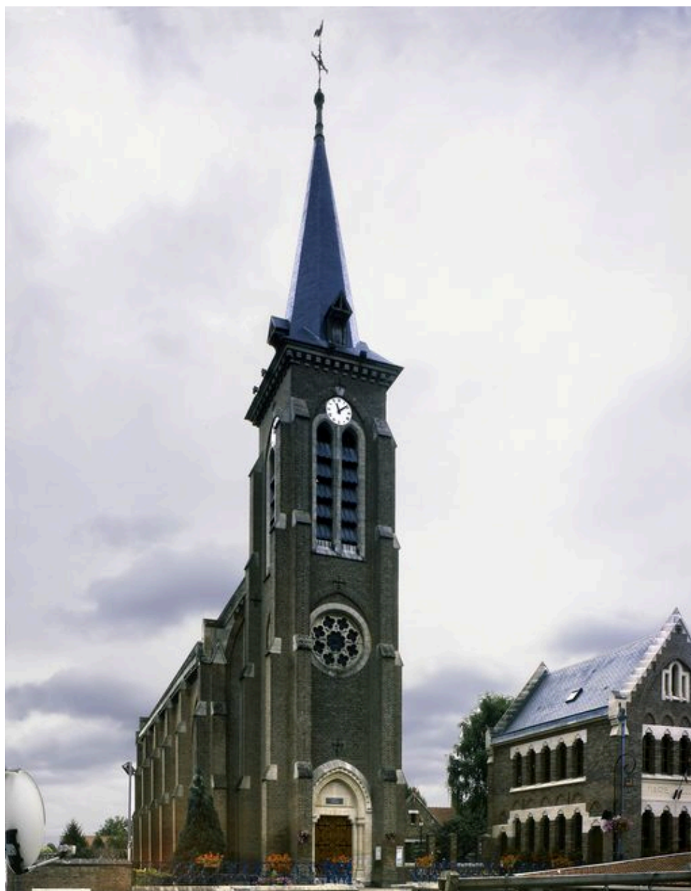
Dreuil-lès-Amiens. Eglise paroissiale et cimetière Saint-Riquier (Charles Céleste Massenot architecte).
