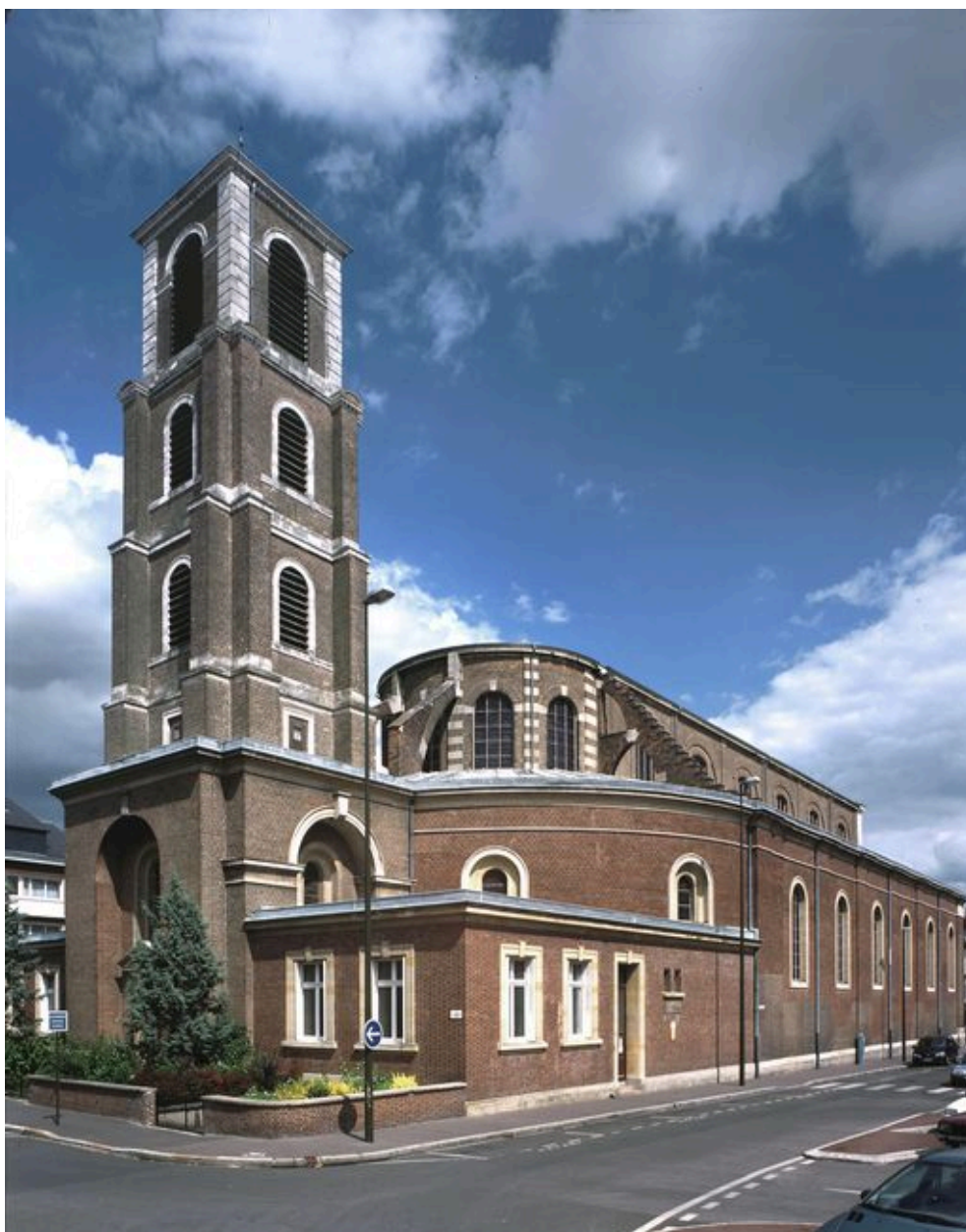
Amiens. Eglise paroissiale Saint-Jacques (François Auguste Cheussey architecte)
