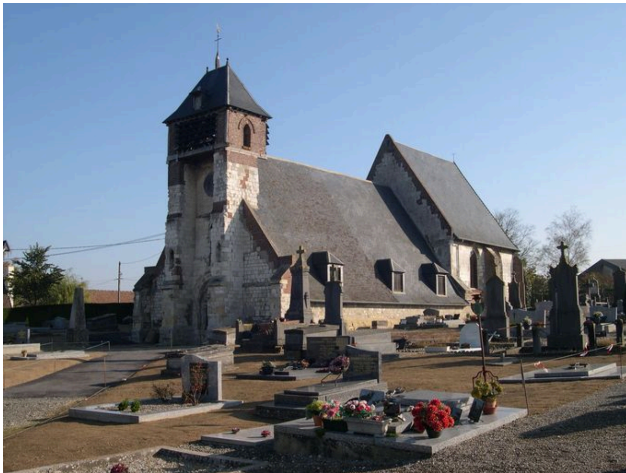
Vers-sur-Selles. Eglise paroissiale et cimetière Saint-Remi et Saint-Hildevert.
