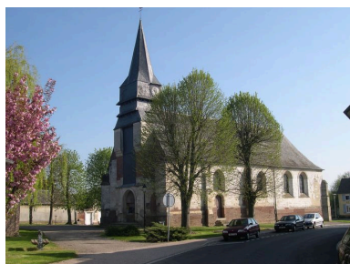
Sains-en-Amiénois. Eglise paroissiale Saints-Fuscien, Victoric et Gentien. Phot. Isabelle Barbedor IVR22_20078012015NUCA
