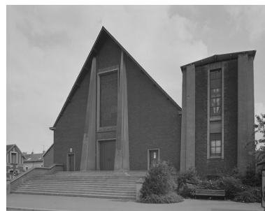
Amiens. Eglise du Coeur- immaculé-de-Marie (Mallet et Carpentier architectes). Phot. Thierry Lefébure IVR22_19968000249V
