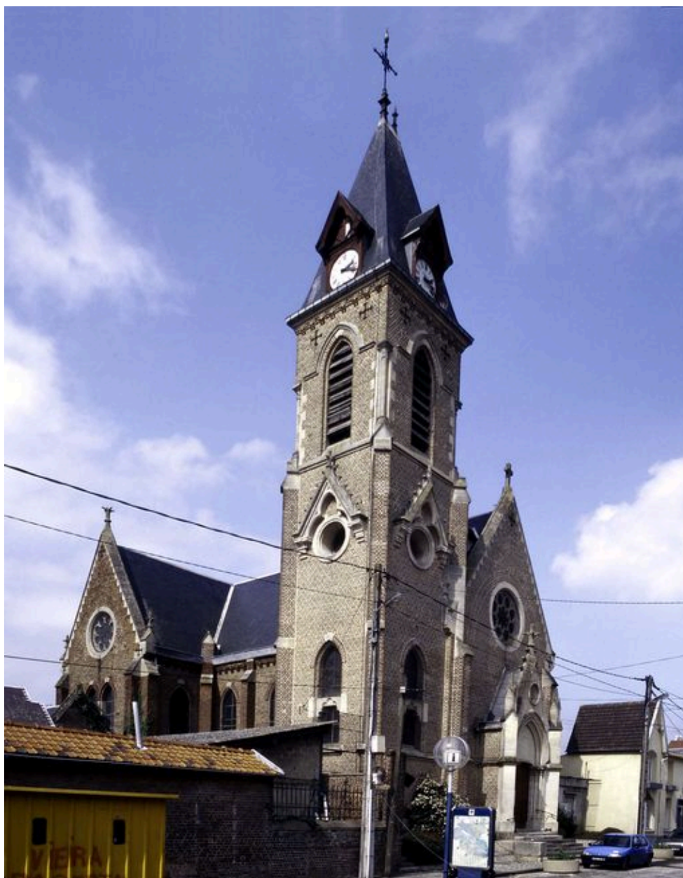
Amiens (Longpré-lès-Amiens). Eglise paroissiale Saint-Léger (Henri Parent architecte).
