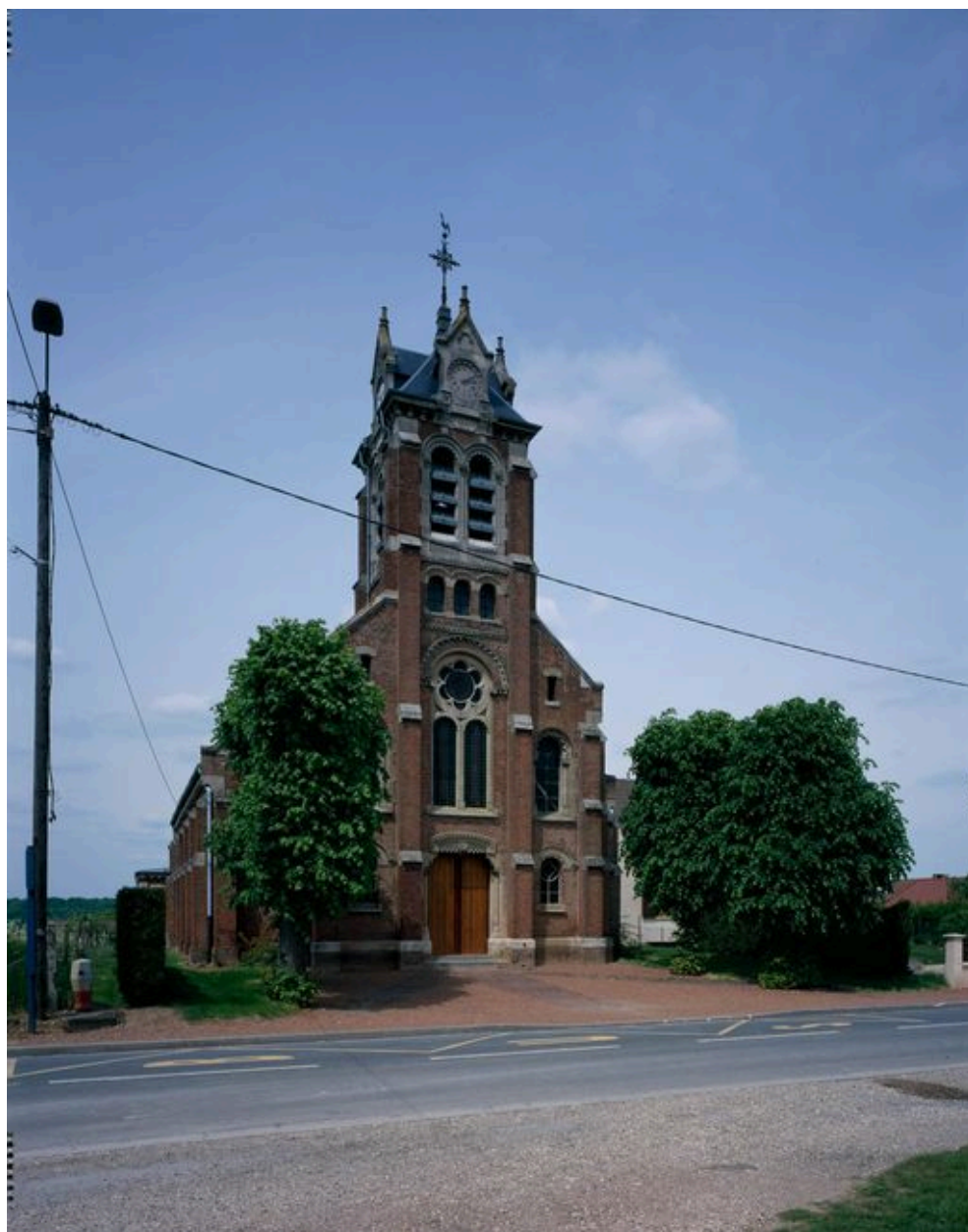
Saint-Fuscien. Eglise Saint-Fuscien (Paul Viénot architecte).
