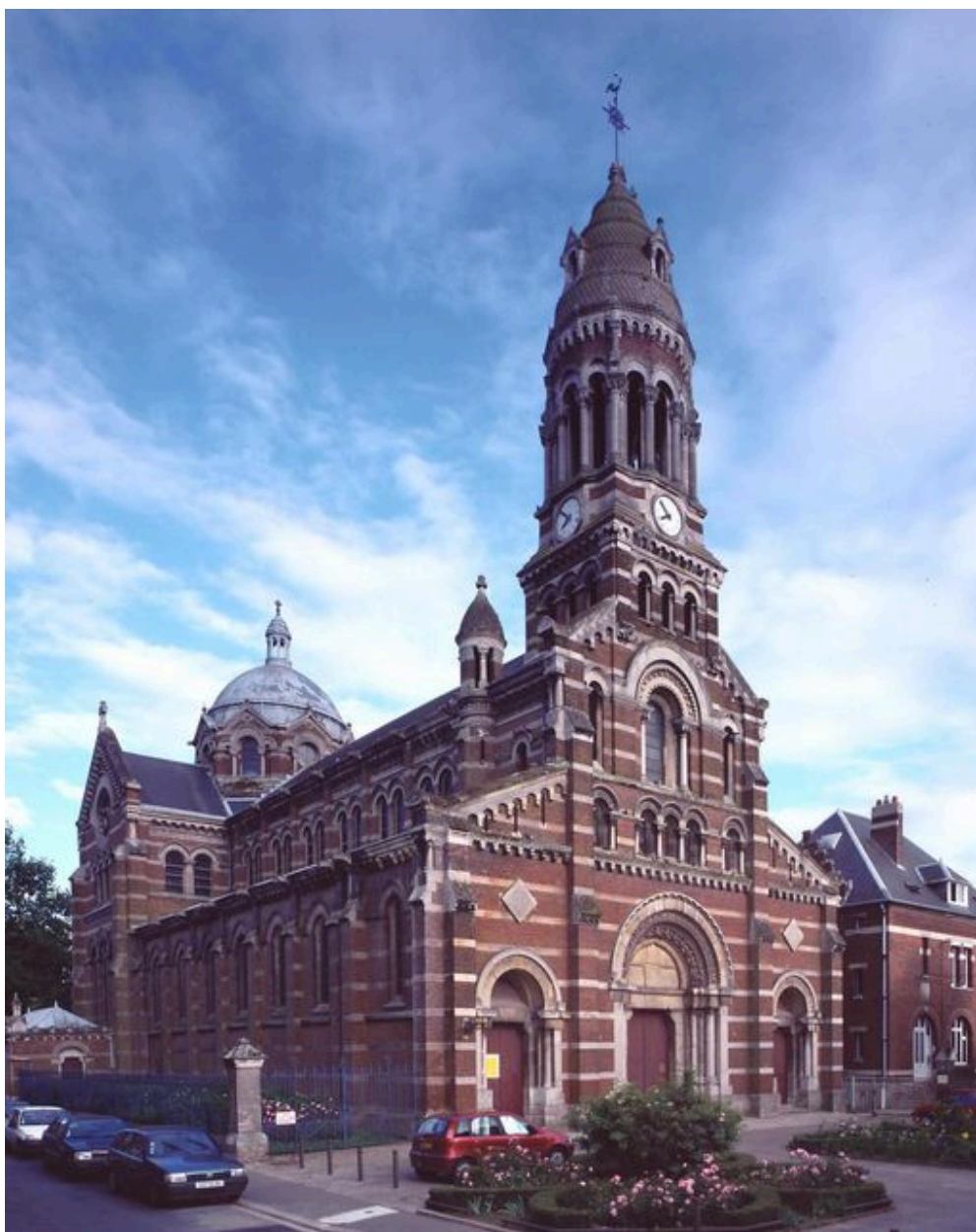
Amiens. Eglise du Sacré-Coeur (Edmond Douillet architecte).
