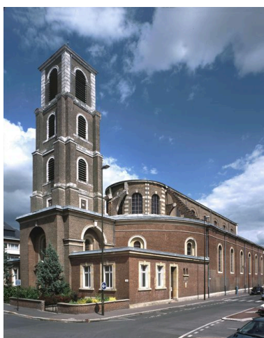
Amiens. Eglise paroissiale Saint-Jacques (François Auguste Chussey architecte) Phot. Thierry Lefébure
