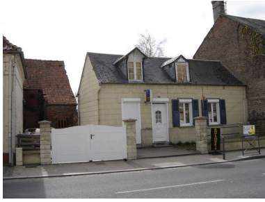
Vue générale. Phot. Inès Guérin IVR22_20058005382NUCA
