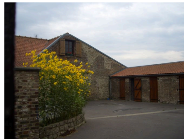
Vue latérale depuis la cour. Phot. Inès Guérin IVR22_20068005490NUCA
