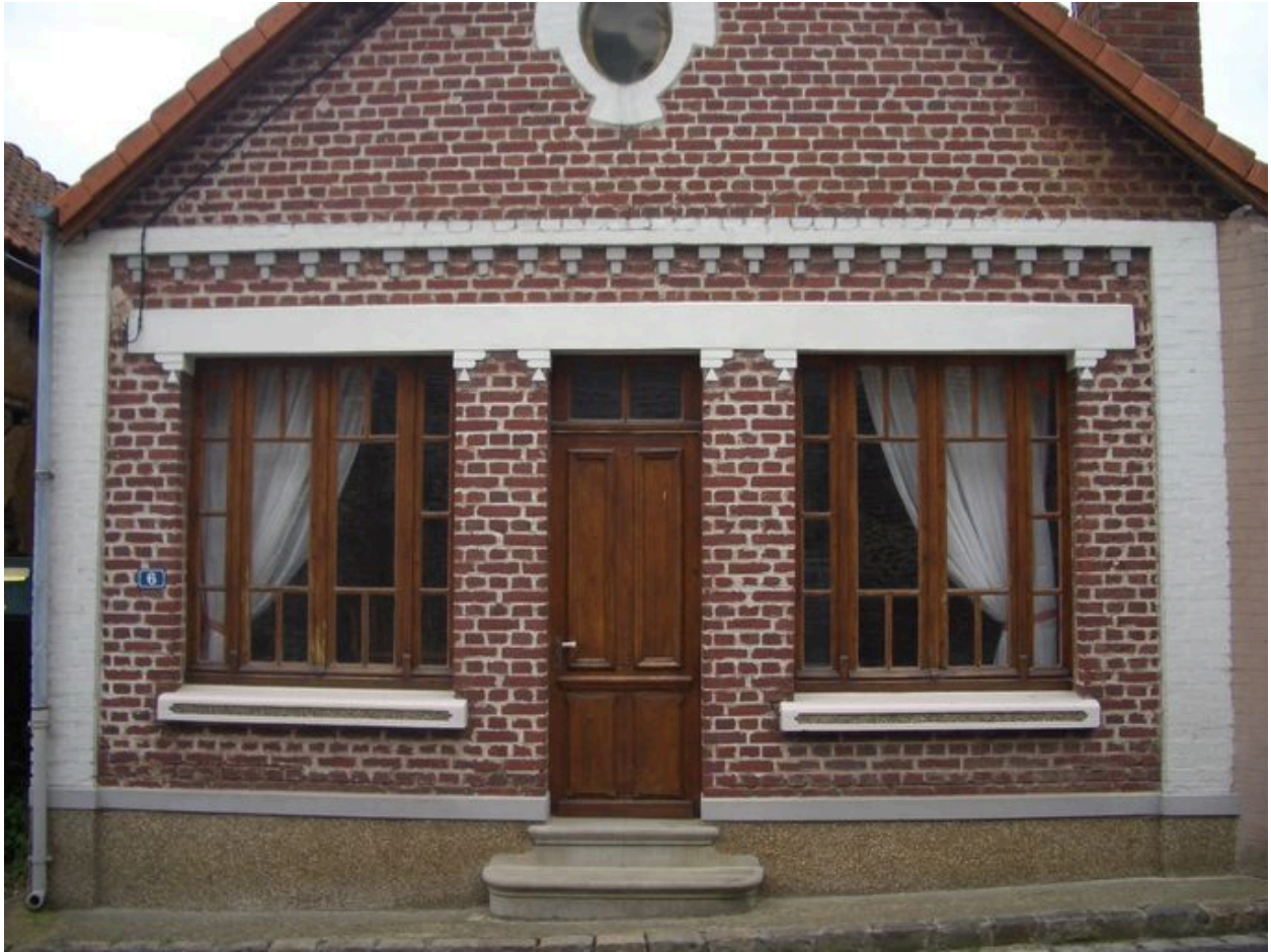
Vue de la face principale du logis.
