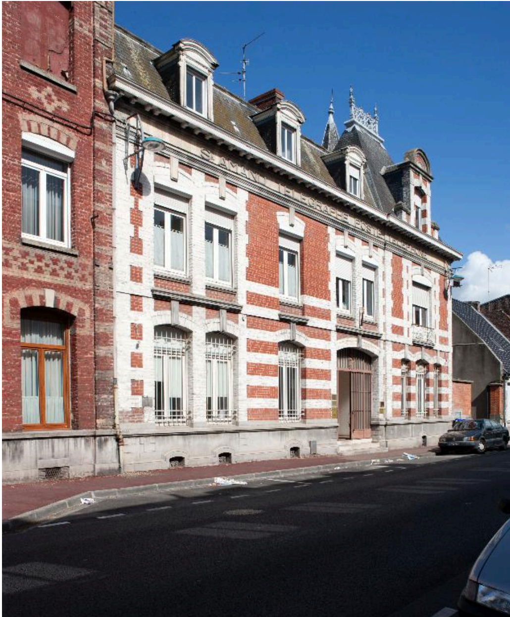
Vue générale de la maison, ancien bureau de poste, actuellement perception.
