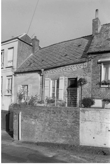
Vue de la façade sur rue. Phot. Pierre-Yves Brest IVR22_19990204348Z
