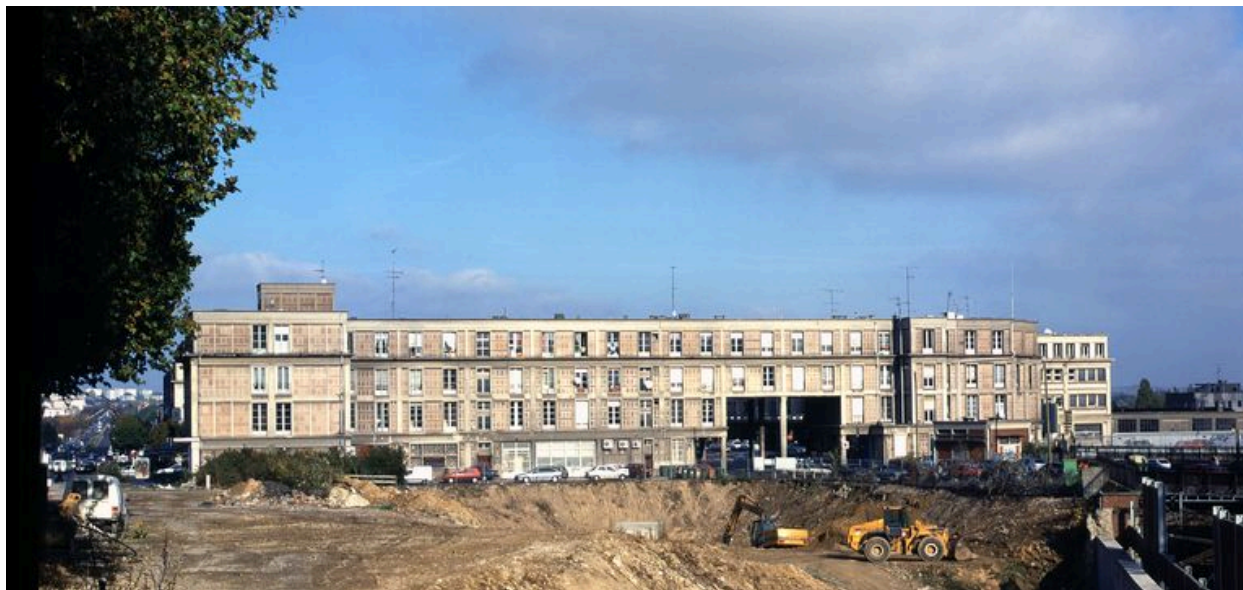
Façade sud de l'immeuble.
