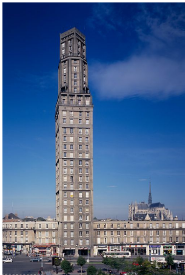
La tour Perret. Phot. Thierry Lefébure IVR22_19978000857XA
