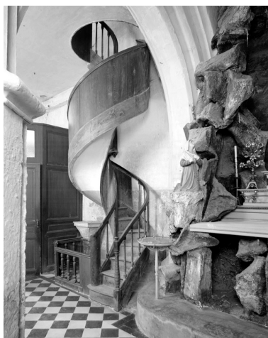
Escalier en colimaçon montant à la tribune, depuis la nef. Phot. Thierry Lefébure IVR22_19978000288V
