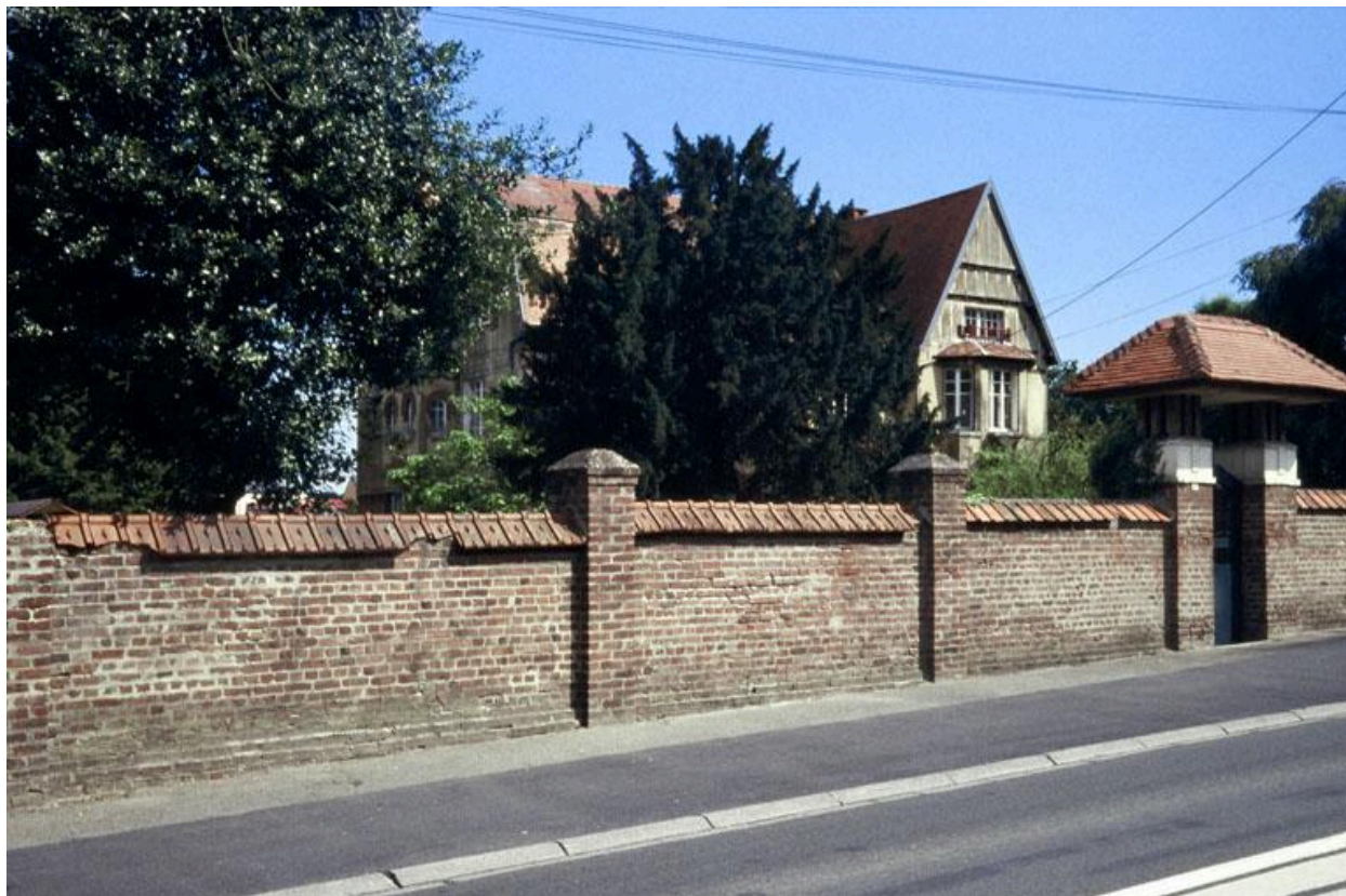
Vue du mur de clôture et du portail d'entrée.
