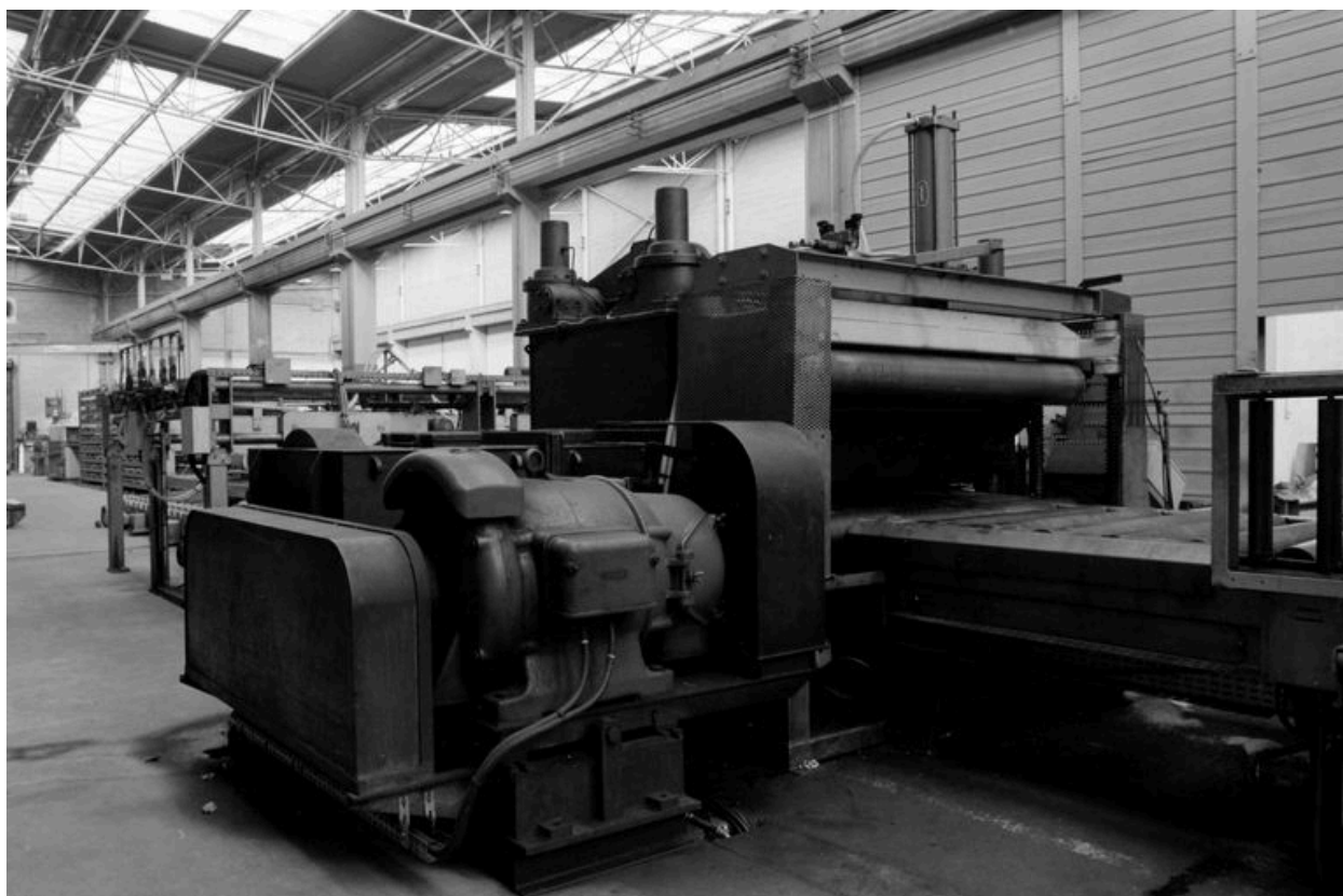
CLAIROIX. Usine d'emboutissage Gantois. Machine de production.
