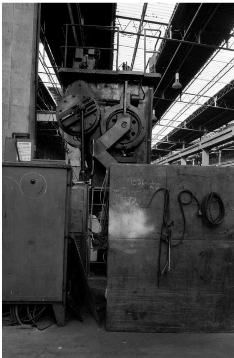
CLAIROIX. Usine d'emboutissage Gantois. Machine de production.
