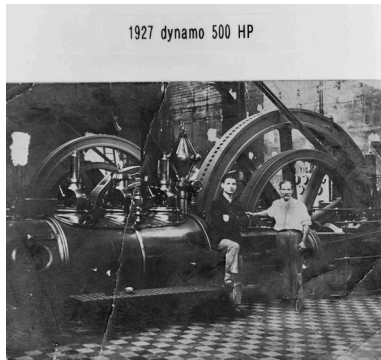
TROSLY-BREUIL. Usine de produits chimiques dite de Cuise-Lamotte ou de Lamotte-Breuil, puis Socindus. Machine à vapeur, en 1927 (AP). Repro. Glotain Patrick IVR22_19936000475XB
