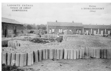
Usine de tuyaux en ciment (détruite). Carte postale avant 1914 (AP). Phot. Jean-Michel Périn (reproduction) IVR22_19856000350XB
