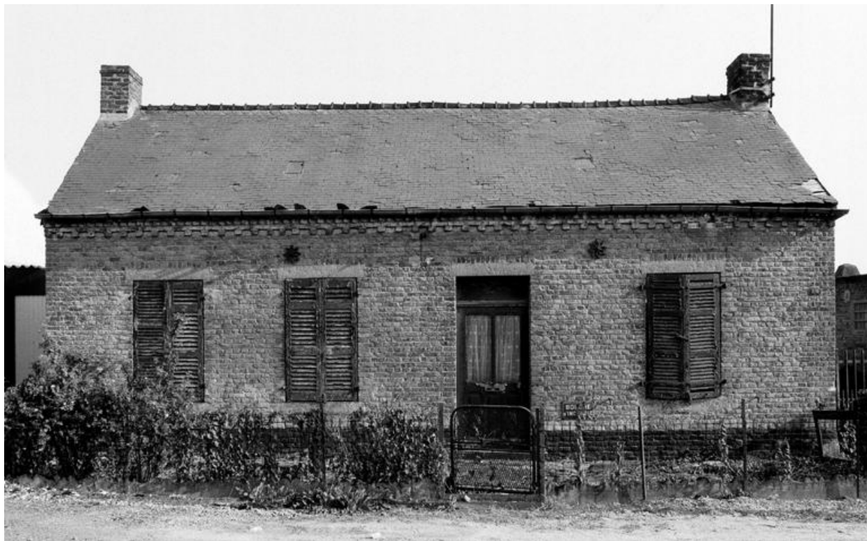
Vue d'ensemble de la façade.
