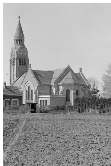
Vue générale sud-est. Phot. Jean-Michel Perrin IVR22_19856000571X
