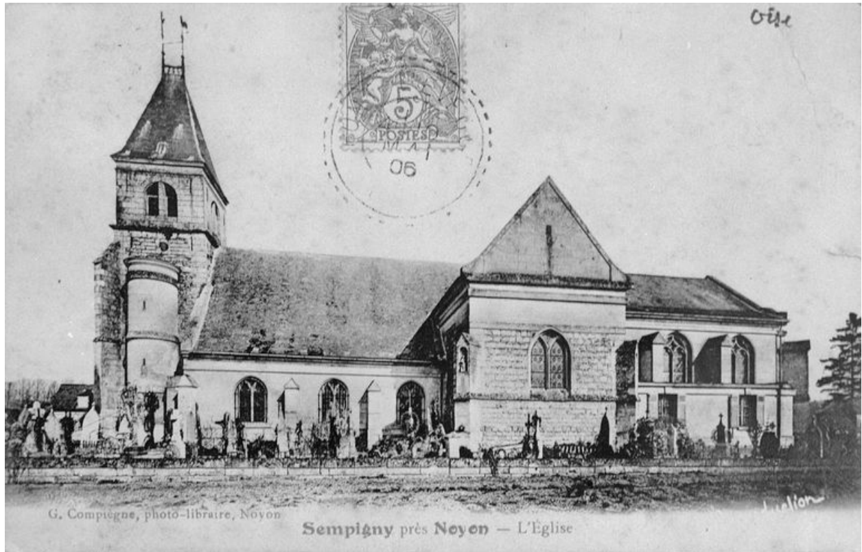
Elévation sud, avant 1914 (AP).
