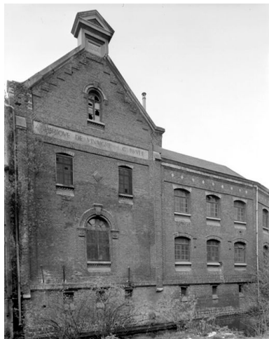
Elévation nord. Phot. Thierry Lefébure IVR22_19908001852V
