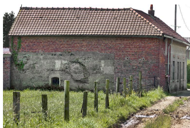
Elévation nord de l'édifice intégré dans un corps de ferme Phot. Jean-Marc Ramette IVR31_20145905495NUCA
