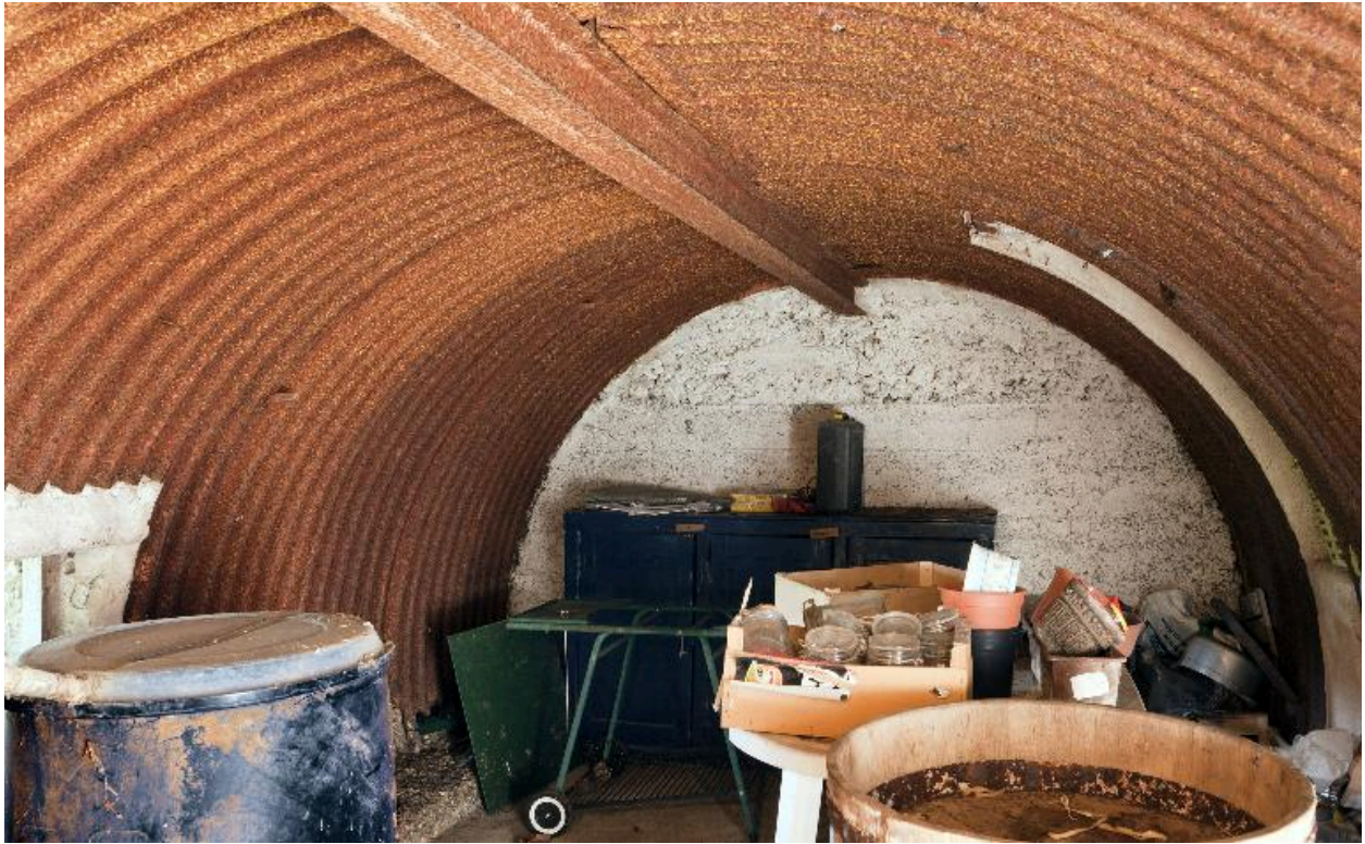
Vue intérieure de la casemate
