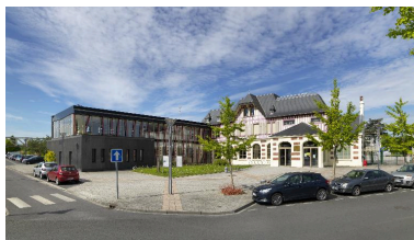
Vue générale de l'ancien buffet de la gare et de son extension en médiathèque. Phot. Thierry Lefébure IVR32_20170200169NUC2AQ
