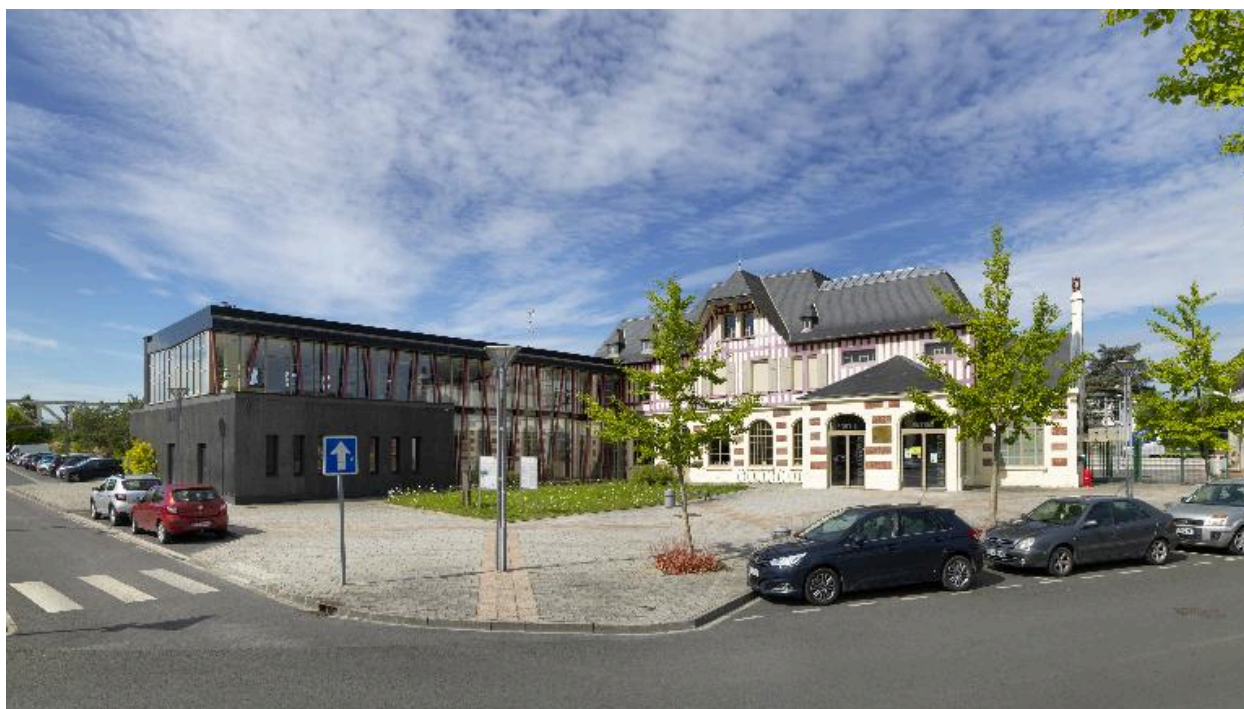
Vue générale de l'ancien buffet de la gare et de son extension en médiathèque.
