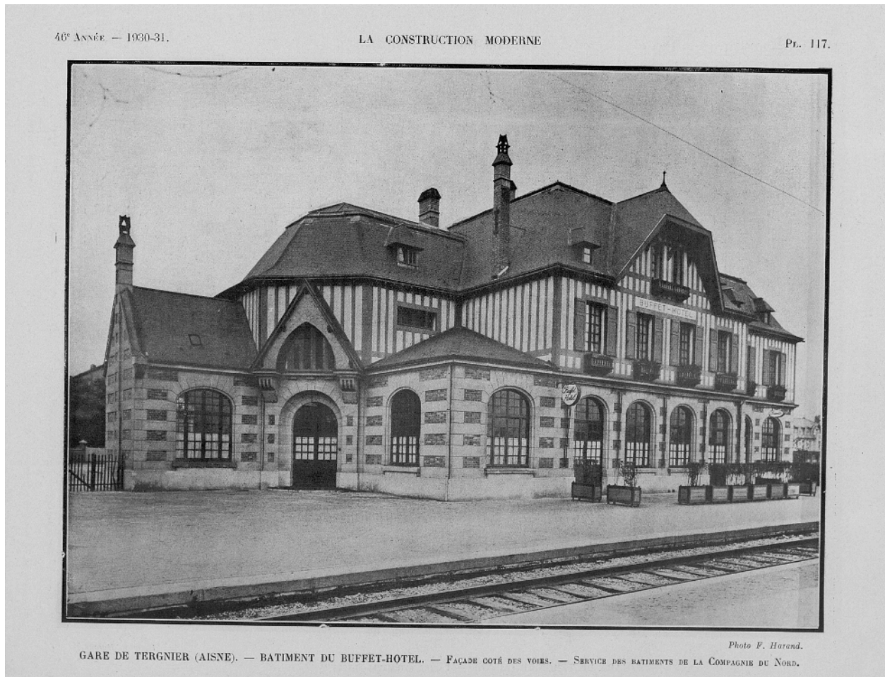
Gare de Tergnier (Aisne). Le buffet-hôtel. Façades côté des voies. Service des Bâtiments de la Compagnie du Nord. La Construction moderne, 1931.
