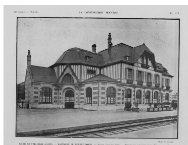
Gare de Tergnier (Aisne). Le buffet-hôtel. Façades côté des voies. Service des Bâtiments de la Compagnie du Nord. La Construction moderne, 1931. Phot. Isabelle Barbedor IVR32_20210205168NUCA
