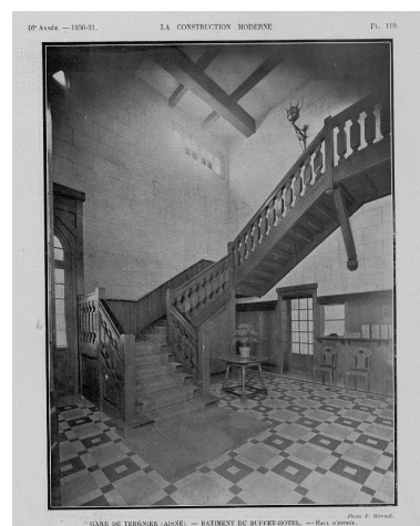
Gare de Tergnier (Aisne). Bâtiment du buffet-hôtel. Hall d'entrée. Service des Bâtiments de la Compagnie du Nord. La Construction moderne, 1931. Phot. Isabelle Barbedor IVR32_20210205170NUCA
