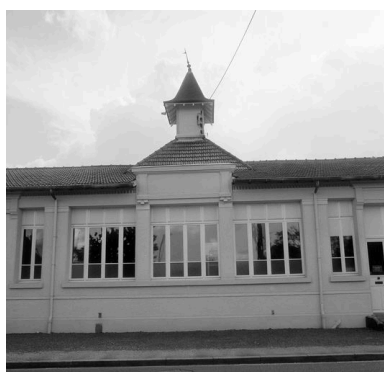
Ecole : détail des travées centrales avec clocheton. Phot. Thierry Lefébure IVR22_20006000603X
