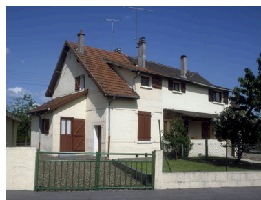
Maisons de cadre en logements jumelés. Phot. Thierry Lefébure IVR22_20006000666XA
