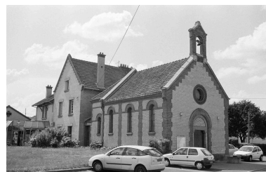
Chapelle : vue générale nord-est. Phot. Bertrand Fournier IVR22_20006000622Z
