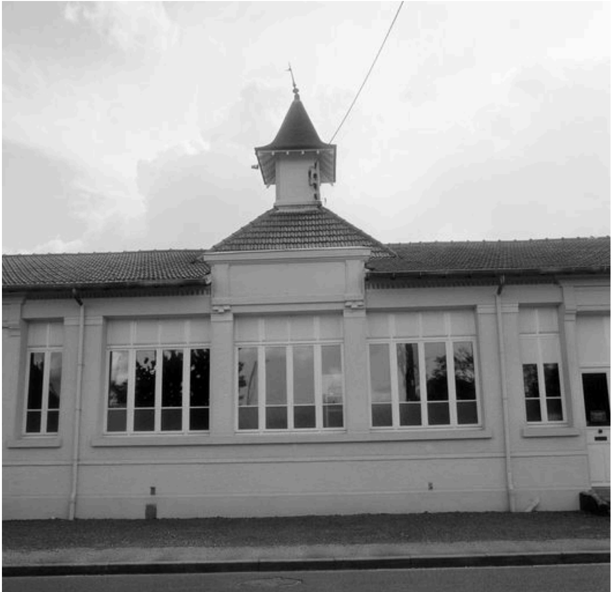
Ecole : détail des travées centrales avec clocheton.
