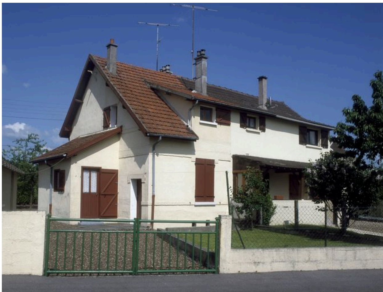
Maisons de cadre en logements jumelés.
