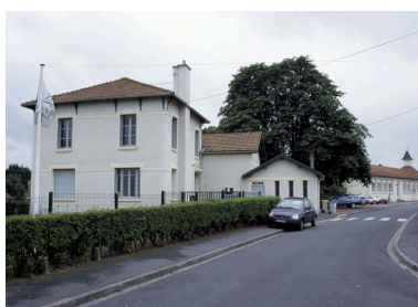
Logement des instituteurs et école. Phot. Bertrand Fournier IVR22_20006000712ZA
