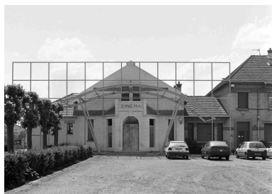
Cinéma : façade principale donnant sur la place. Phot. Thierry Lefébure IVR22_20006000591X
