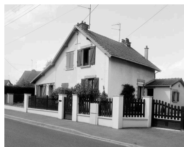
Maisons d'ouvrier en logements jumelés. Phot. Thierry Lefébure IVR22_20006000598X
