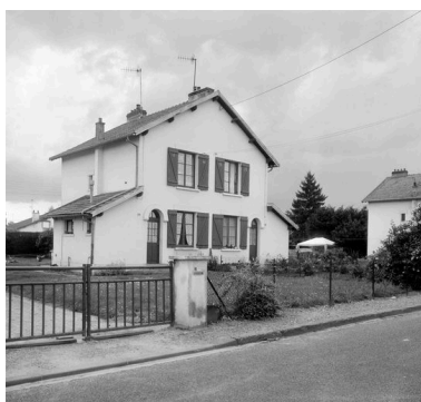
Maisons d'ouvrier en logements jumelés. Phot. Thierry Lefébure IVR22_20006000664X
