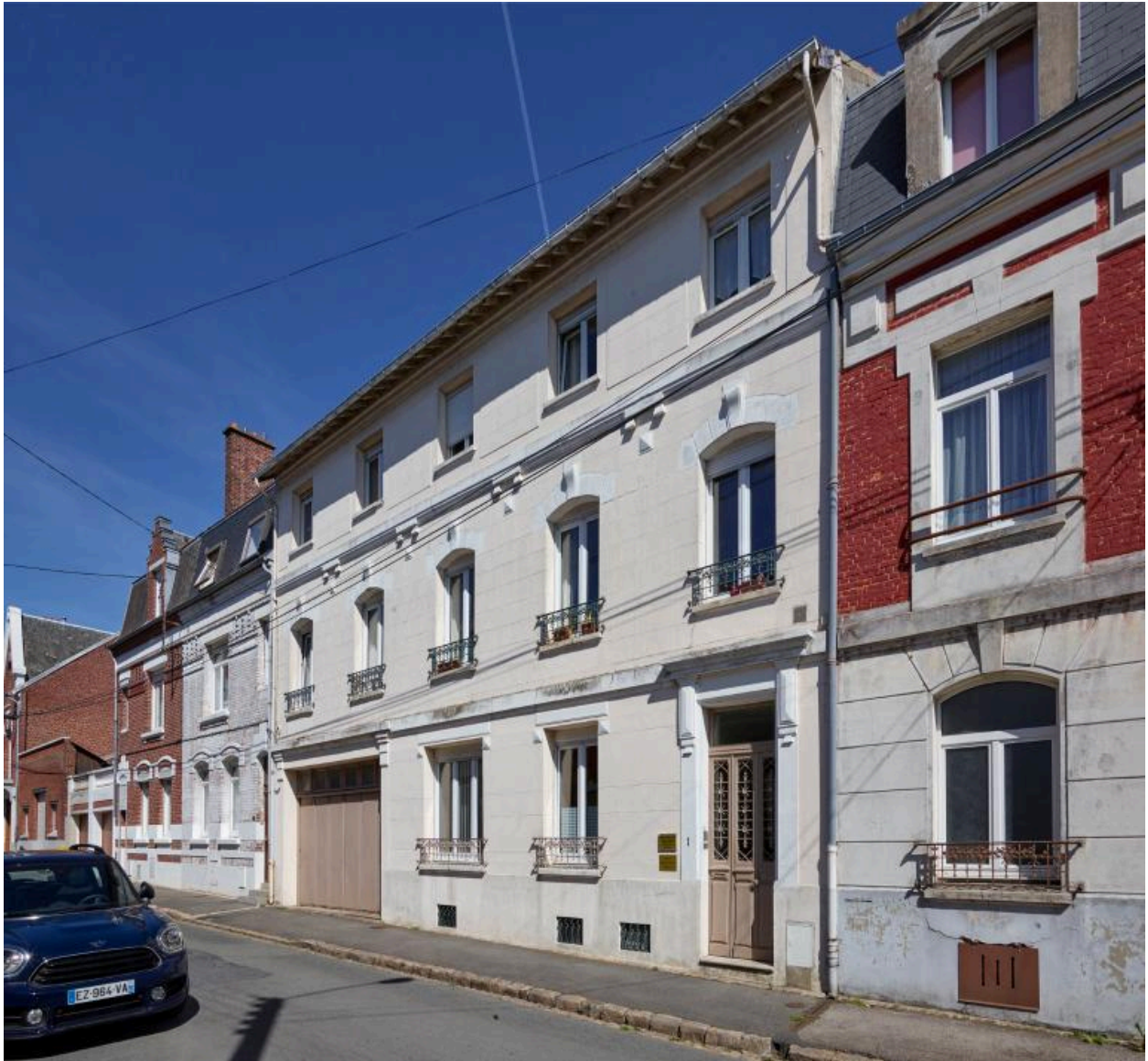
Vue générale de la façade rue Lecointe.
