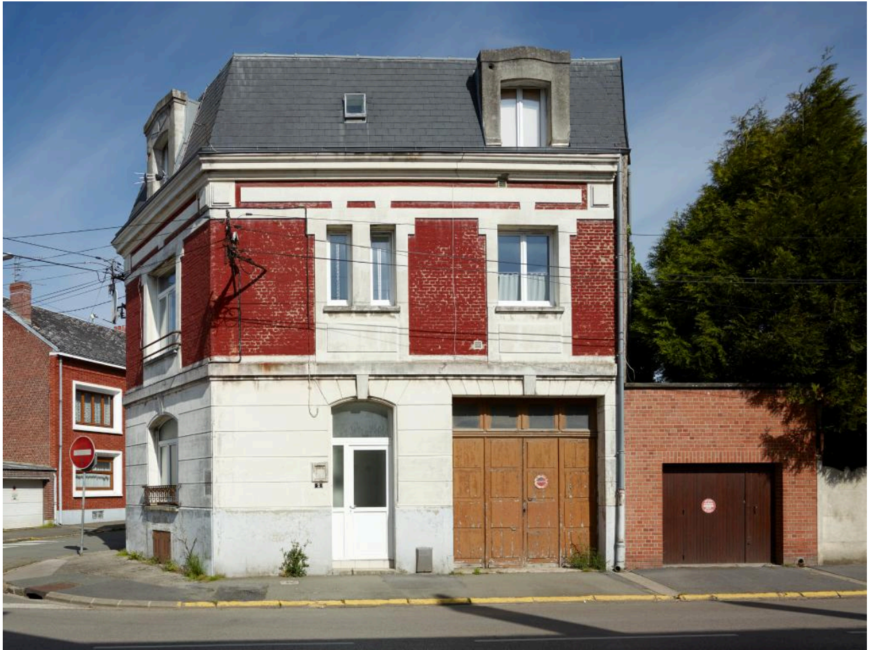
Vue générale de la façade rue de Douai.
