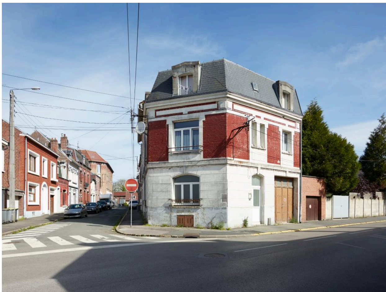
Vue générale de la façade rue de Douai et de l'angle sur la rue Lecointe.
