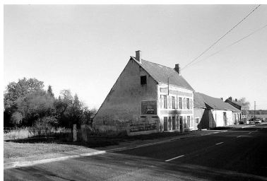
Vue générale : logis et grange depuis le sud-ouest. Phot. Xavier-Philippe Guiochon IVR22_19970202599Z
