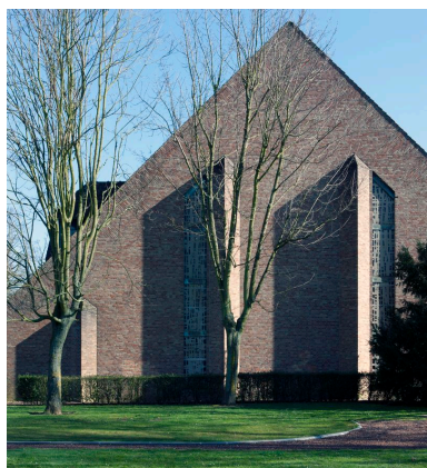
Contrefort de l'élévation sud.
