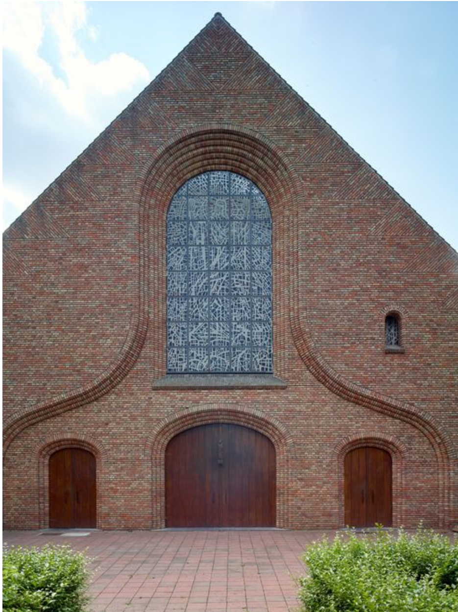
Élévation antérieure de l'église.
