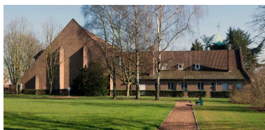
Élévation sud. Phot. Pierre Thibaut IVR31_20145903196NUCA
