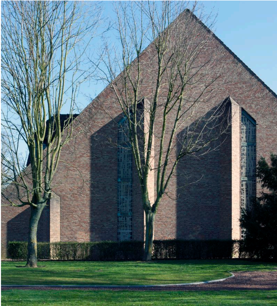
Contrefort de l'élévation sud.
