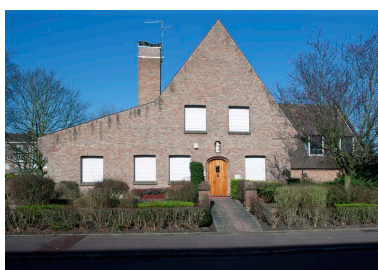
Presbytère accolé sur la face est. Phot. Pierre Thibaut IVR31_20145903198NUCA
