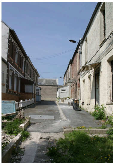
Deuxième groupe de 7 logements. Phot. Frédéric Pillet IVR22_20070205164NUCA
