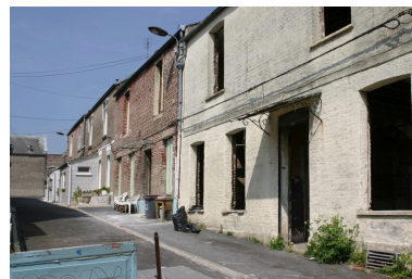
Groupe de 4 logements. Phot. Frédéric Pillet IVR22_20070205165NUCA
