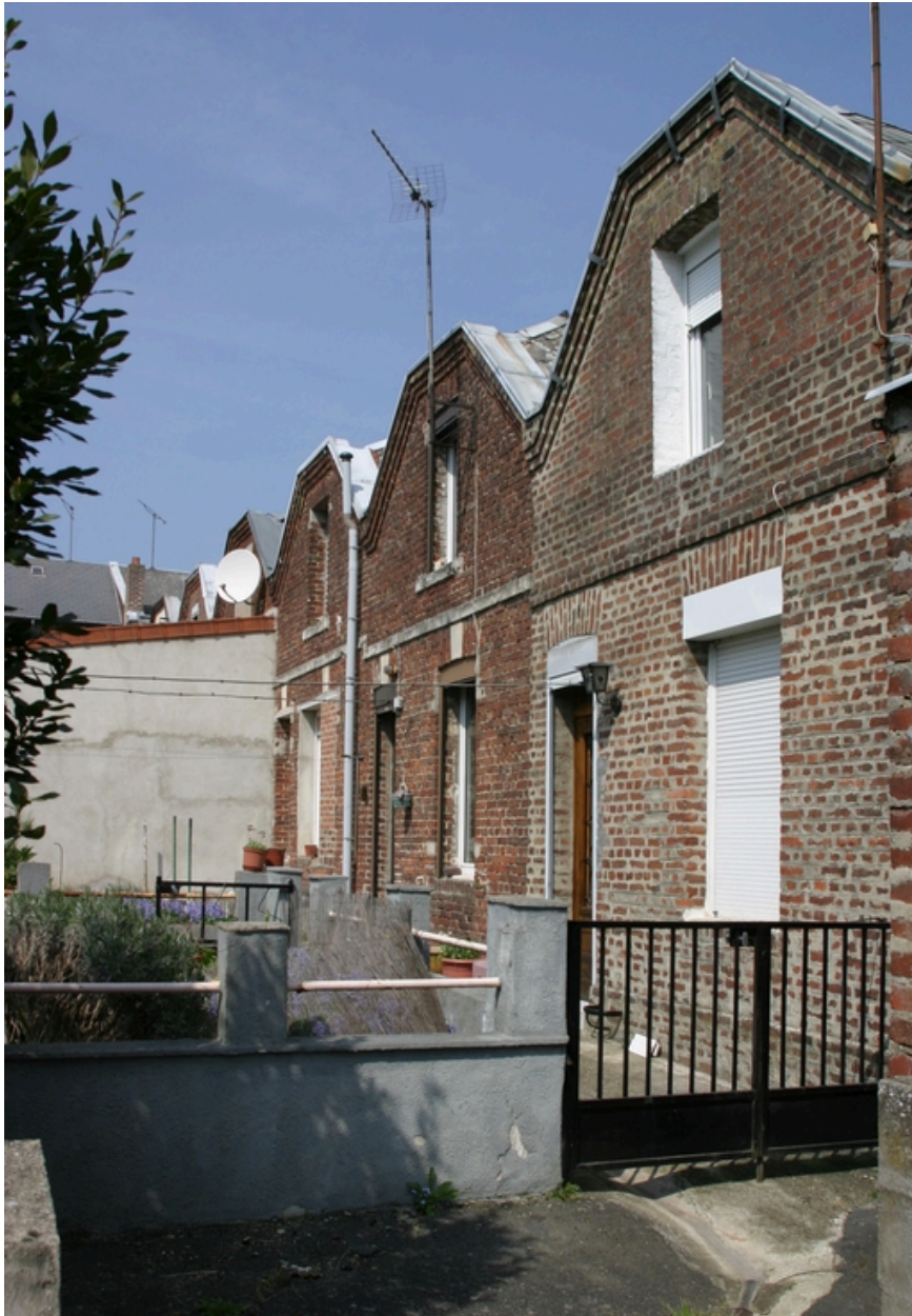
Premier groupe de six logements : façade postérieure.
