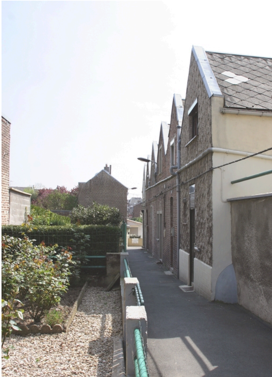
Entrée de la cour Datra (premier groupe de six logements).
