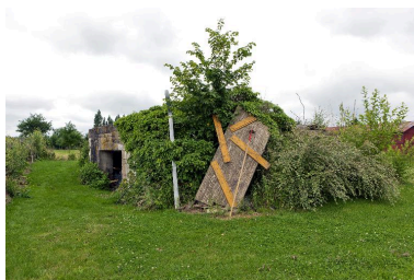
Vue vers le sud Phot. Jean-Marc Ramette IVR31_20145904104NUCA
