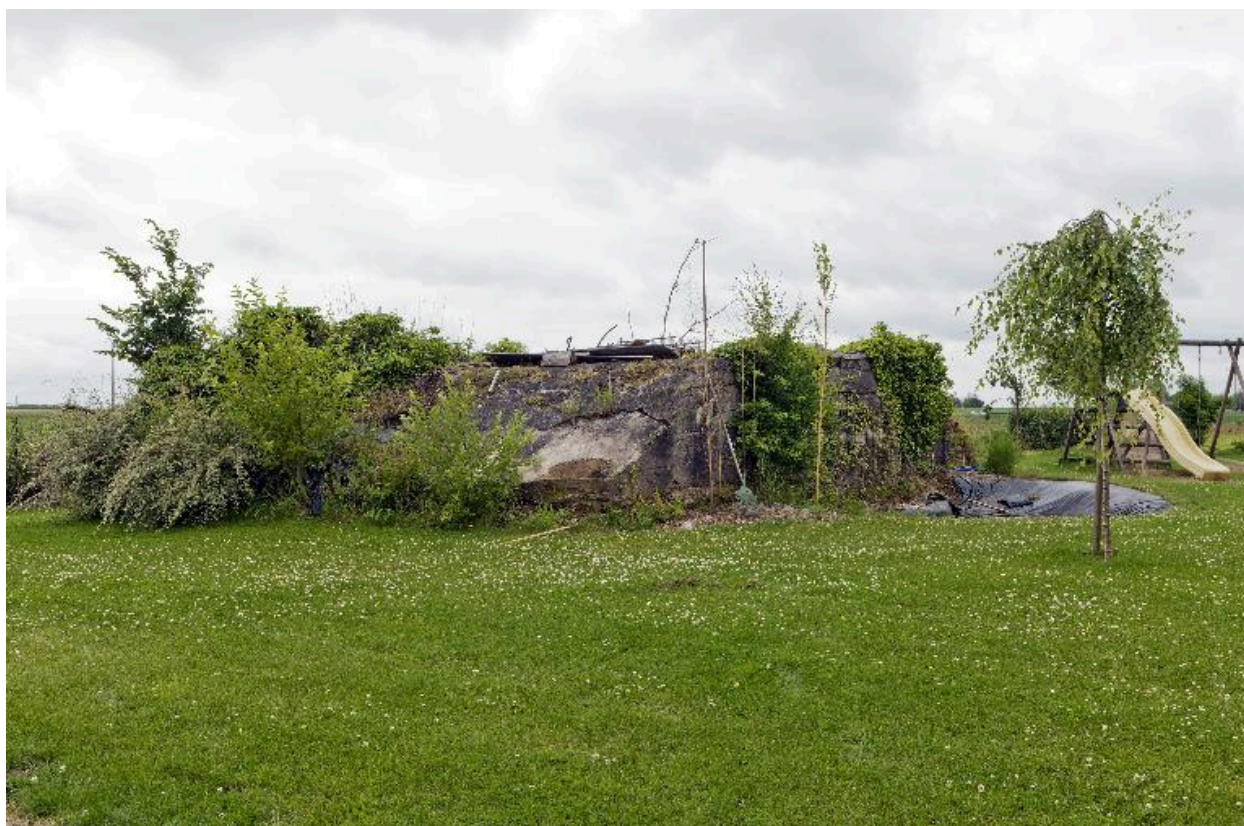
Vue vers le sud-est
