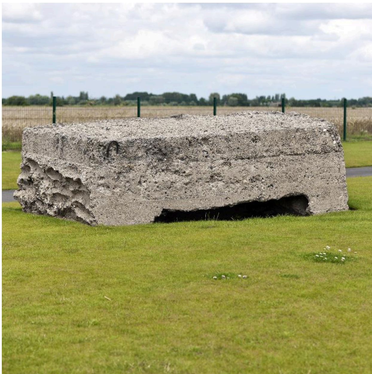
La casemate (a), vers le nord-ouest
