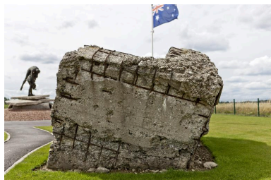
Vestiges de la casemate (e) retournée lors de l'explosion d'une mine, vers le sud-ouest Phot. Jean-Marc Ramette IVR31_20145904704NUCA
