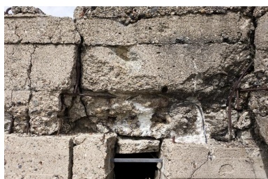
Casemate (f), détail du ferrailage Phot. Jean-Marc Ramette IVR31_20145904703NUCA
