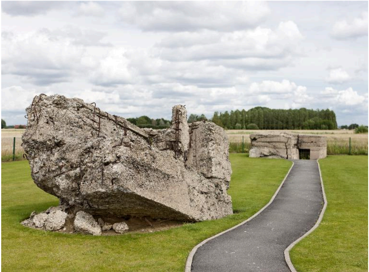
Vestiges de la casemate (e) retournée lors de l'explosion d'une mine, vers le nord-ouest
