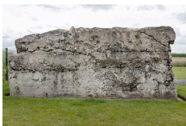
Casemate (f), vers le sud Phot. Jean-Marc Ramette IVR31_20145904709NUCA
