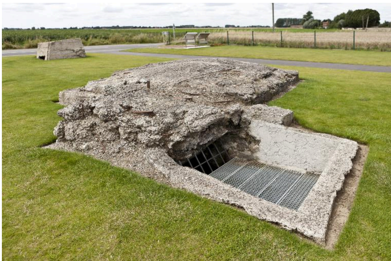
Casemate (b) vers le nord-ouest
