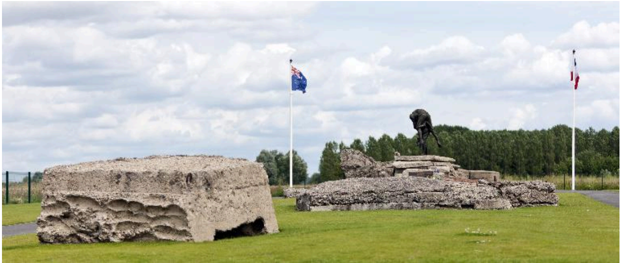
Vue générale depuis la rue Delval, vers le nord-est. Au premier plan la casemate (a)
