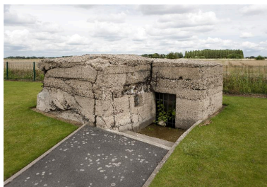
Casemate (f), vers le nord-est Phot. Jean-Marc Ramette IVR31_20145904708NUCA
