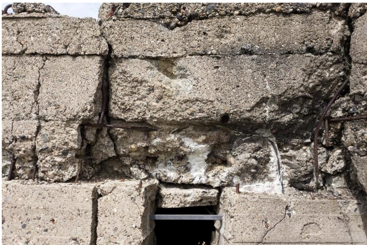
Casemate (f), détail du ferrailage
