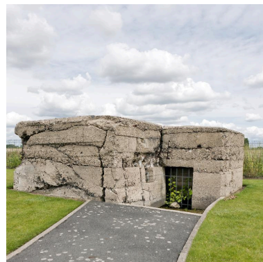
Casemate (f), vers le nord-est Phot. Jean-Marc Ramette IVR31_20145904707NUCA
