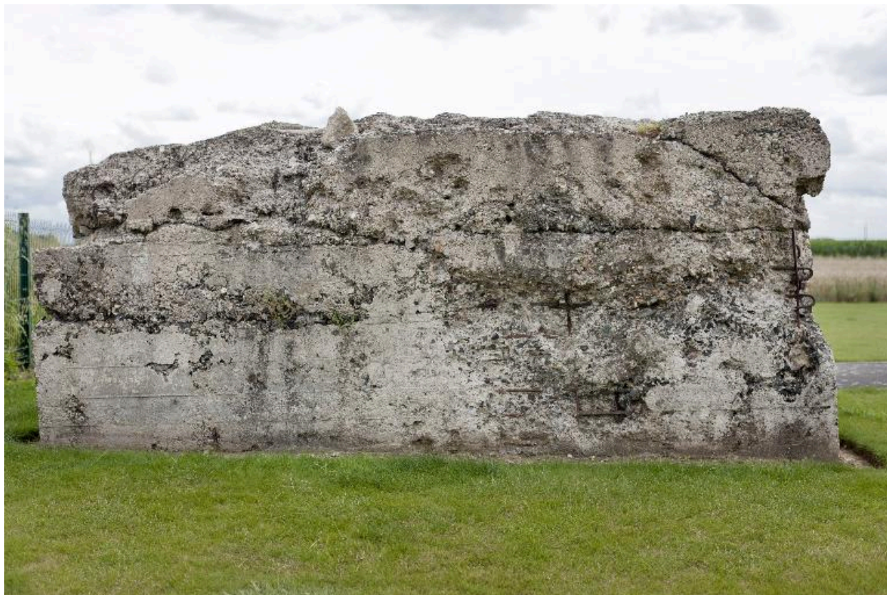
Casemate (f), vers le sud
