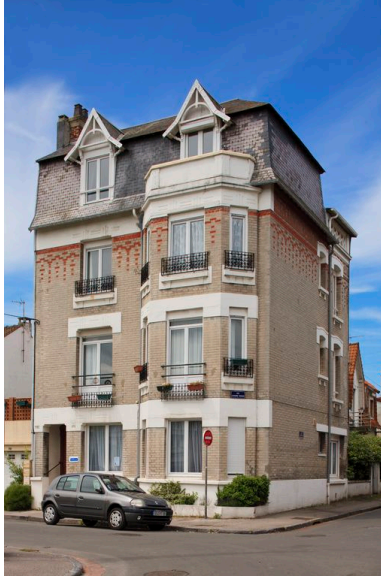
Vue générale de l'immeuble. Phot. Hubert Bouvet IVR31_20136200192NUCA
