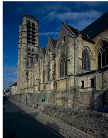
Vue générale du bas côté sud depuis la rue Saint-Crépin. Phot. Thierry Lefébure IVR22_19940200824VA
