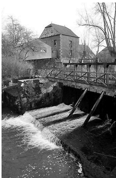
Vue des bâtiments du moulin et du barrage. Phot. Benoît Dufournier IVR22_19910202291Z
