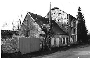
Vue du logis et du moulin. Phot. Benoît Dufournier IVR22_19910202292Z
