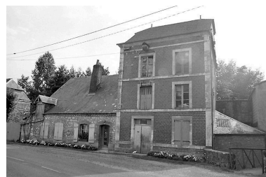
Vue générale depuis le nord-est. Phot. Xavier-Philippe Guiochon IVR22_19980202776Z
