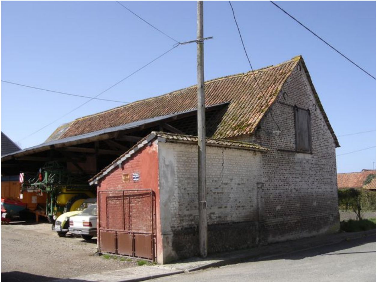
Vue de la grange.
