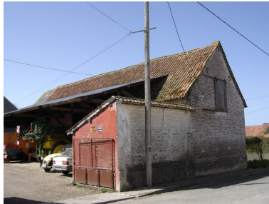
Vue de la grange. Phot. Inès Guérin IVR22_20058005501NUCA
