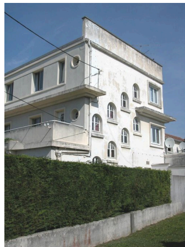
Détail de la façade latérale droite, avec vue sur les baies cintrées de la cage d'escalier. Phot. Elisabeth Justome IVR22_20058003140NUCA
