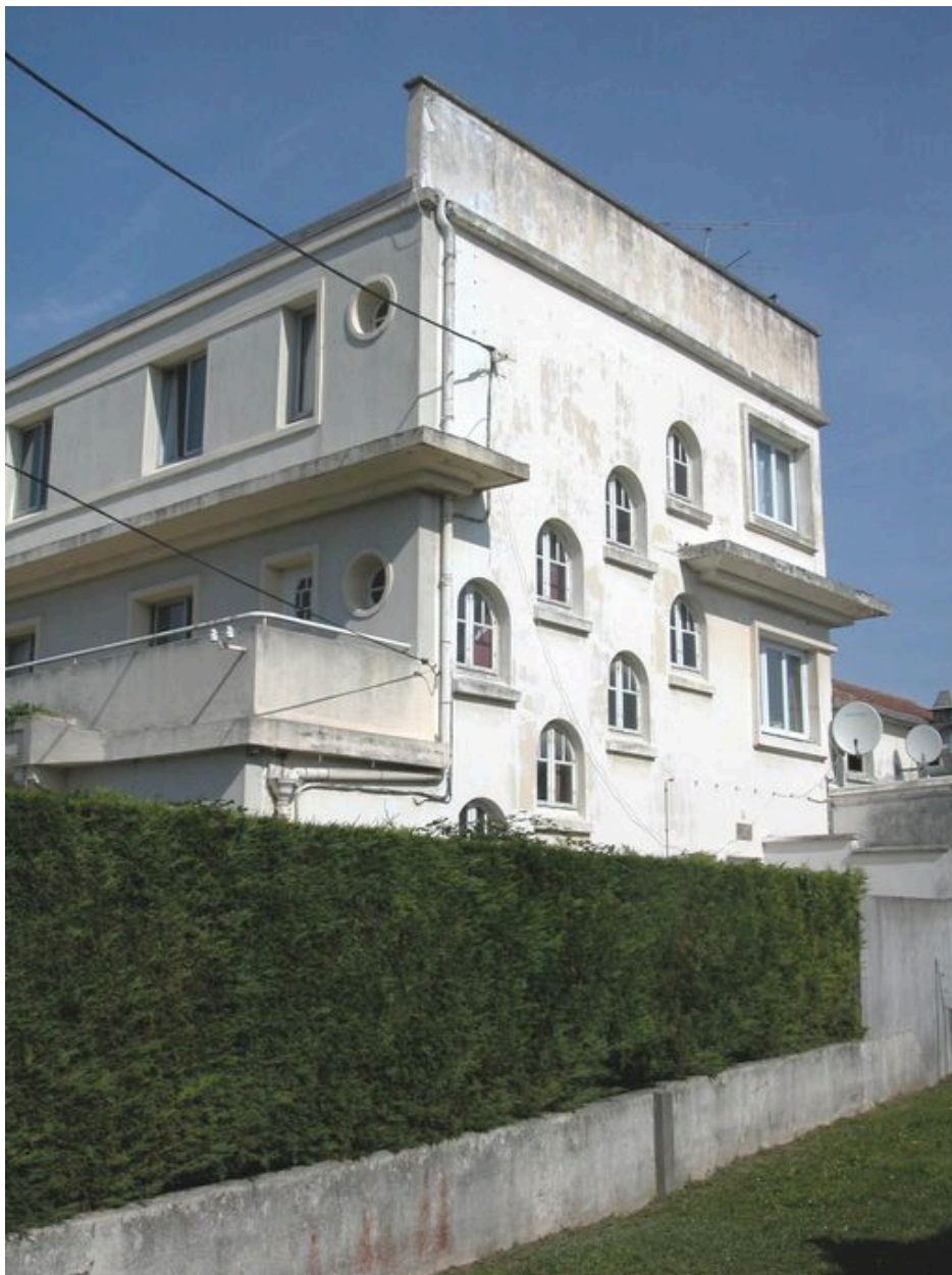
Détail de la façade latérale droite, avec vue sur les baies cintrées de la cage d'escalier.
