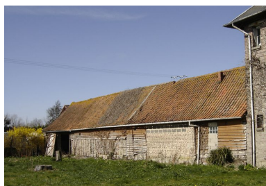
Vue des anciennes dépendances agricoles situées dans la cour, parallèlement au restaurant sur rue. Phot. Inès Guérin IVR22_20058005396NUCA
