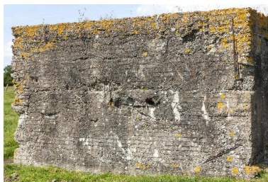
Elévation ouest. On remarque les empreintes de briques ainsi que 3 tuyaux traversant la paroi (destinés au passage de câbles ?) Phot. Jean-Marc Ramette IVR31_20145905362NUCA
