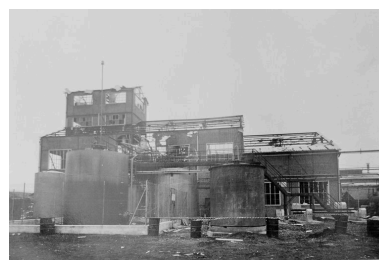
L'atelier de trichloréthylène après l'explosion de 1960 (AP). Repro. Glotain Patrick IVR22_19936000489XB
