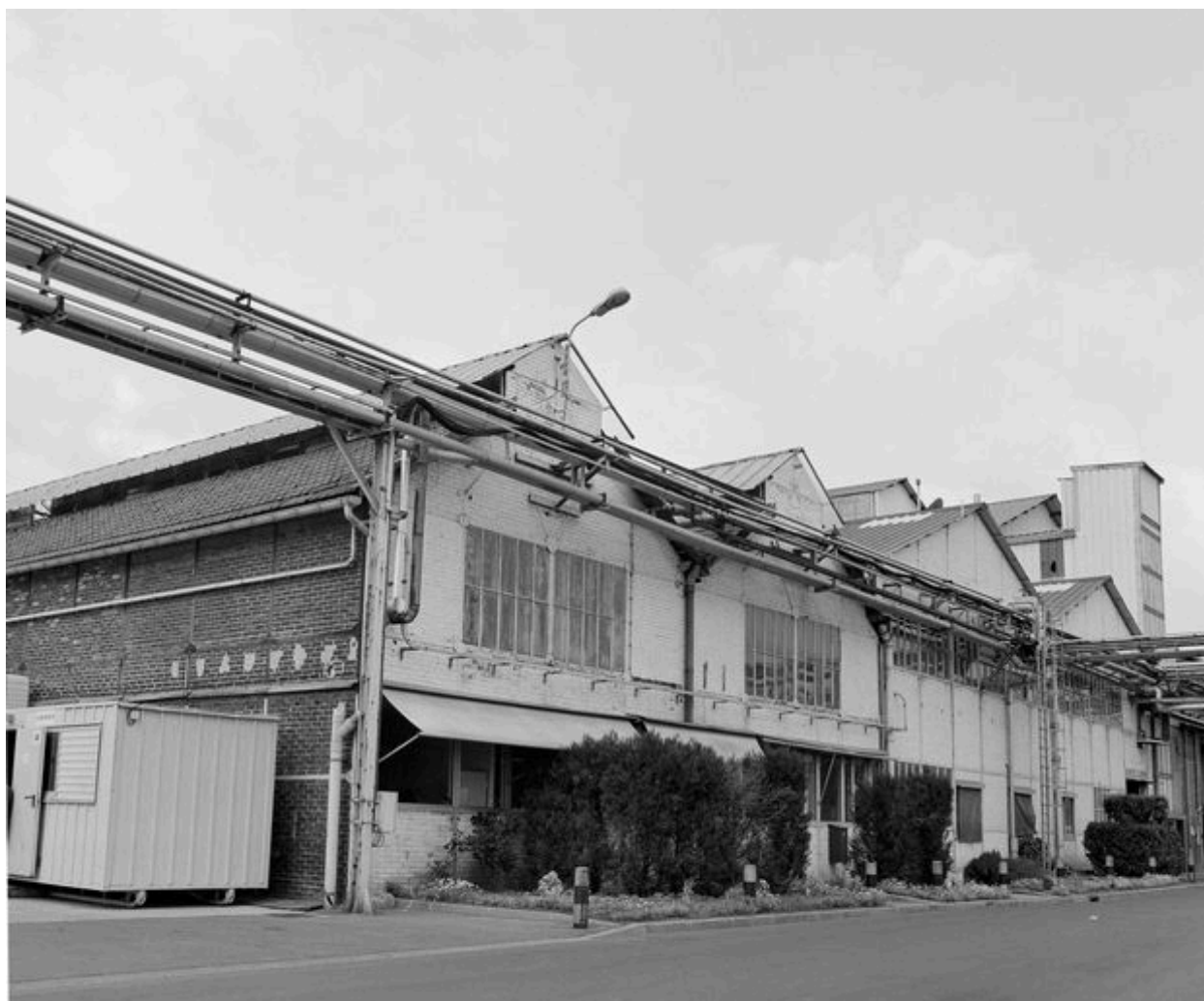
Atelier de fabrication antérieur à 1960.
