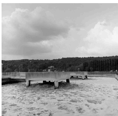
La station d'épuration construite vers 1970. Phot. Patrick Glotain IVR22_19936000553X
