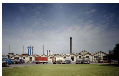
Ateliers de fabrication : flanc sud. Phot. Patrick Glotain IVR22_19936001810VA
