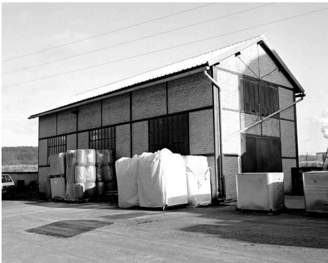
Chaufferie : flanc nord.
