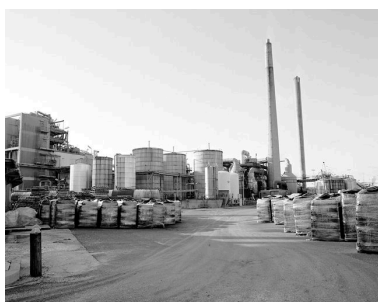
Réservoirs industriels. Phot. Thierry Lefébure IVR22_19926000341X
