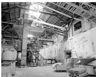
Atelier de fabrication : vue intérieure. Phot. Thierry Lefébure IVR22_19926000347X
