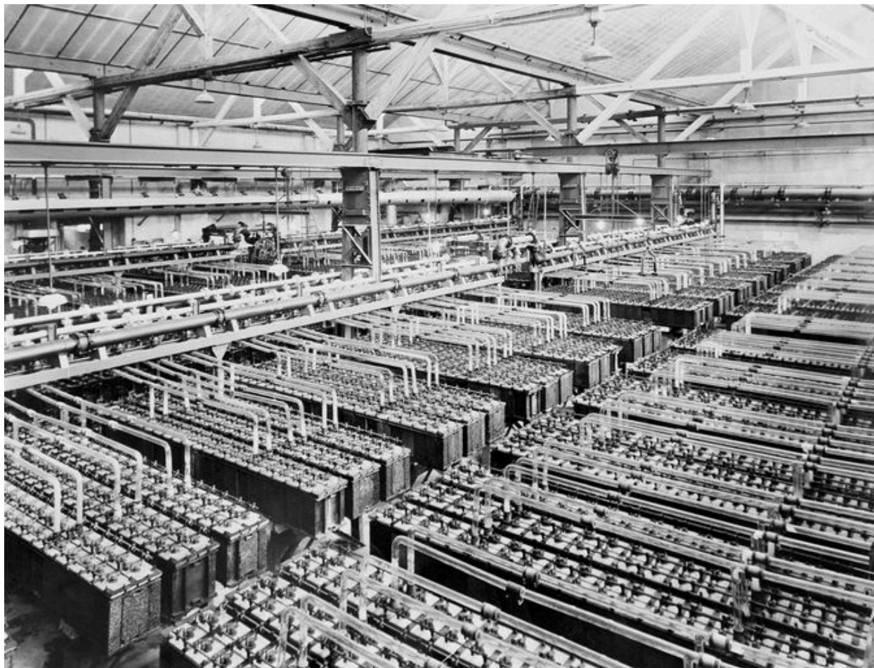
Vue intérieure de l'atelier d'électrolyse (AP).
