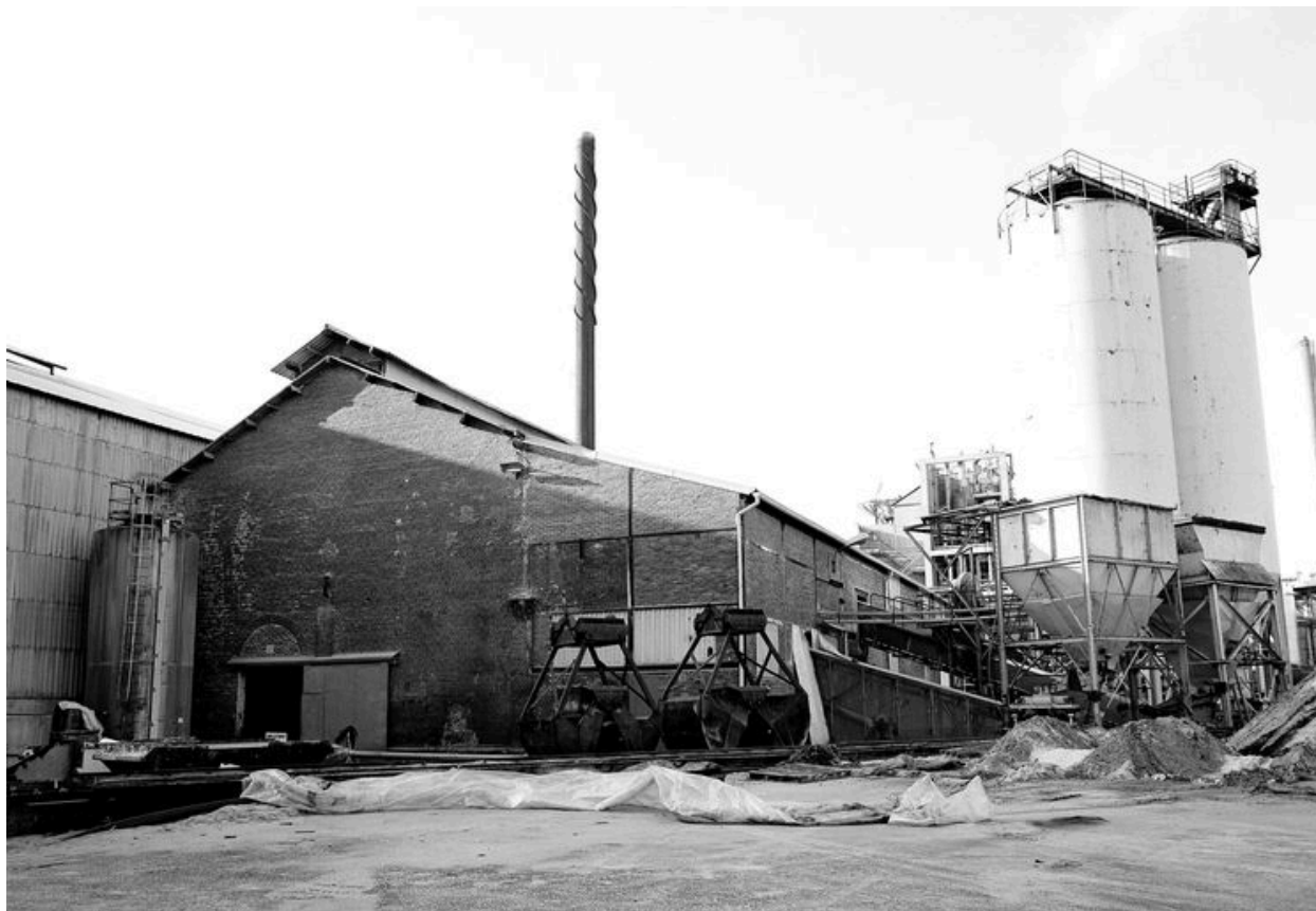
Atelier de fabrication et réservoirs industriels : flanc nord.
