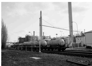
Voie ferrée. Phot. Thierry Lefébure IVR22_19926000355X
