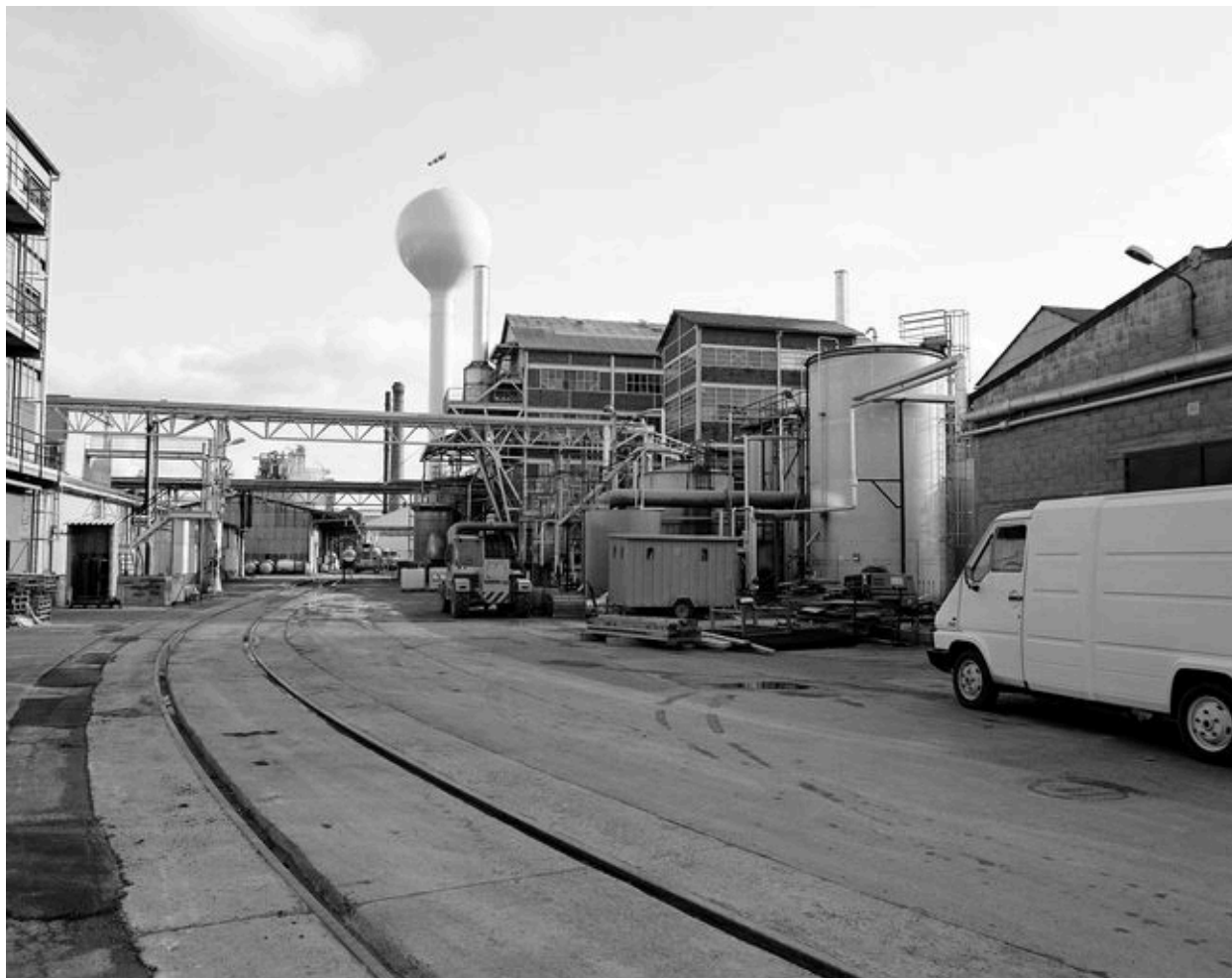
Atelier de fabrication et château d'eau.
