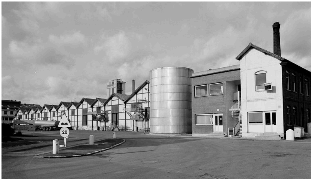
Atelier de fabrication construit en 1895-1896.
