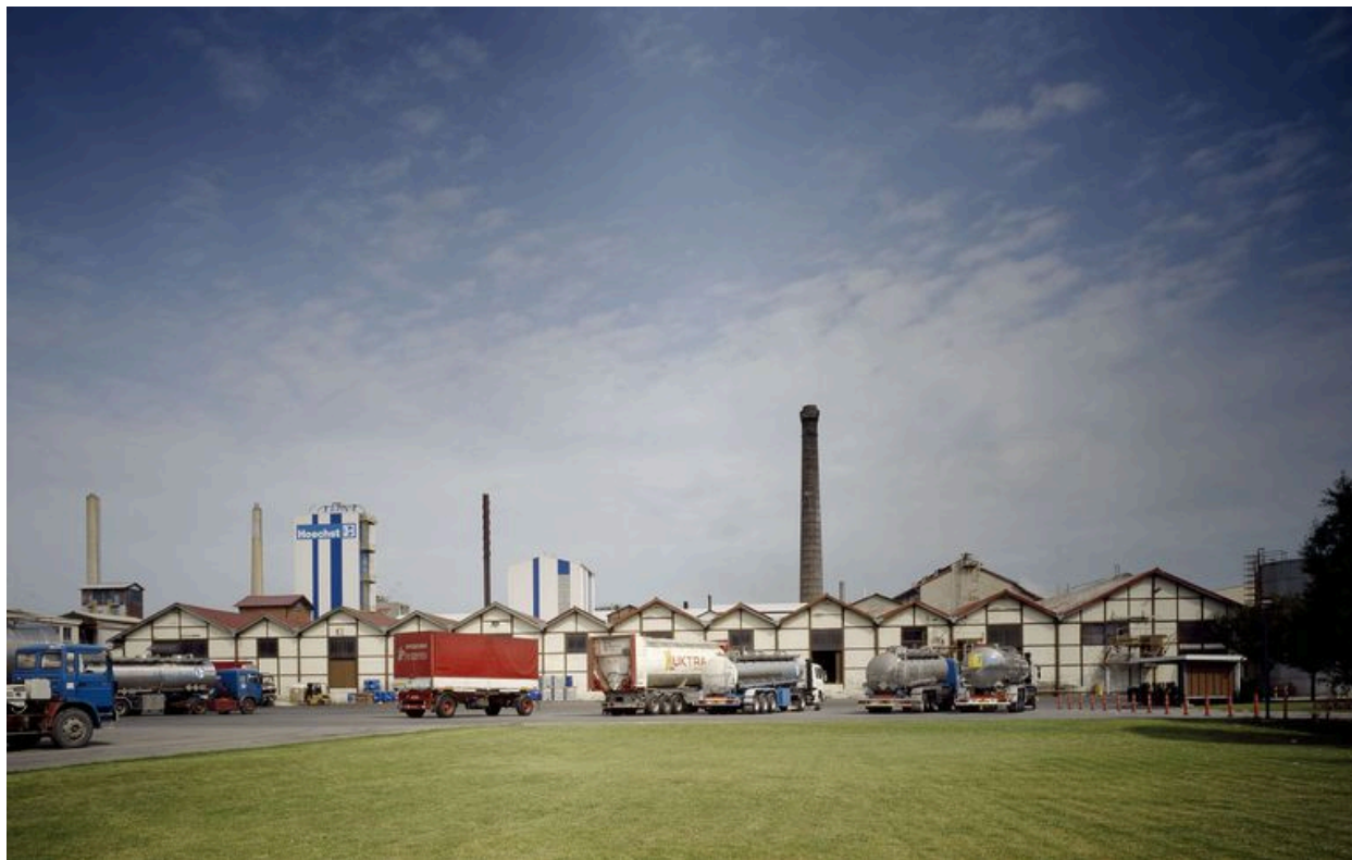
Ateliers de fabrication : flanc sud.
