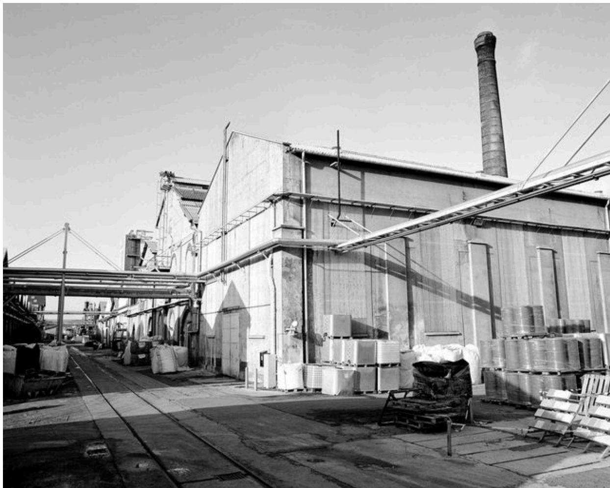
Chaufferie : flanc sud est.
