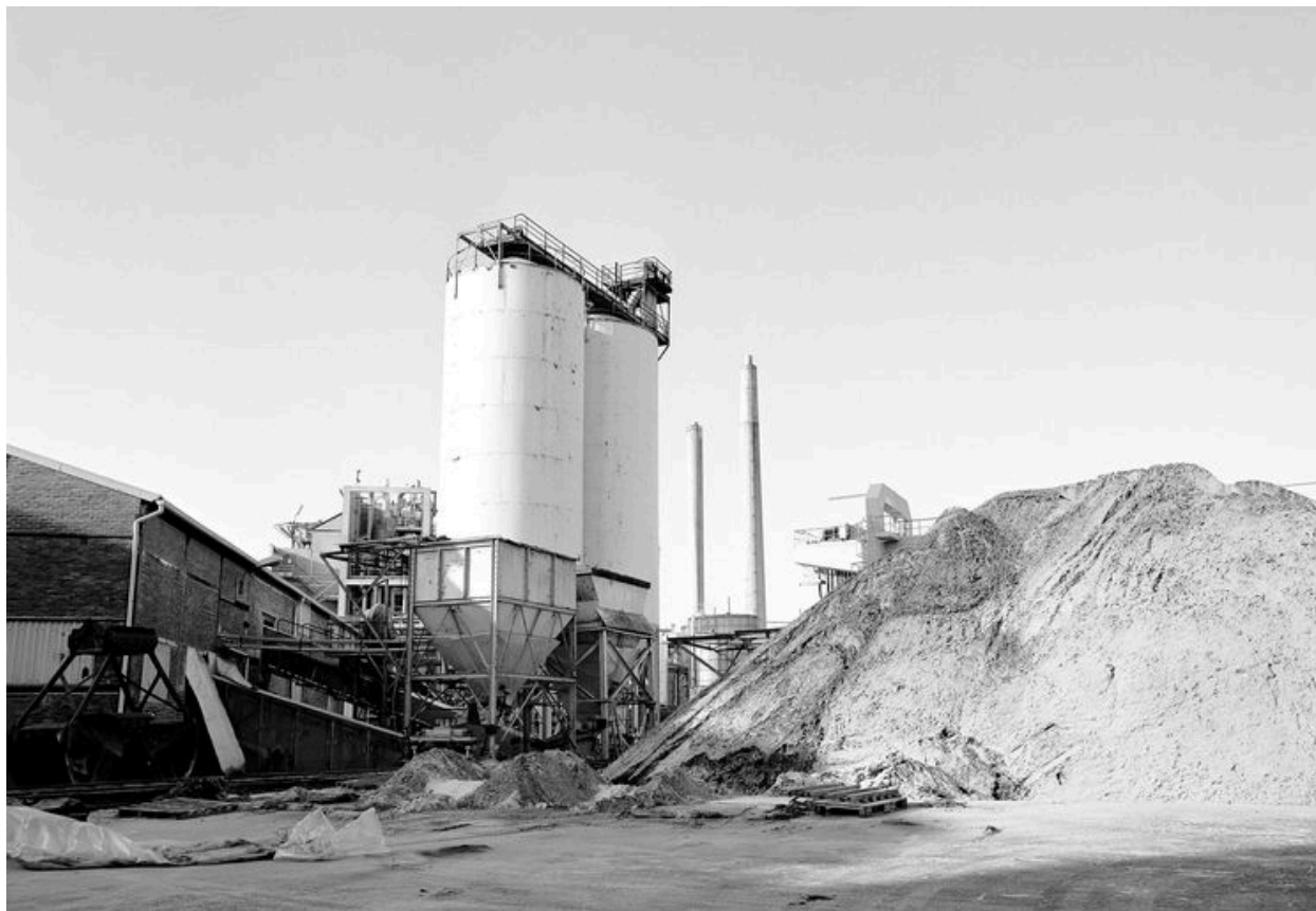
Aire des matières premières et réservoirs industriels : flanc nord.
