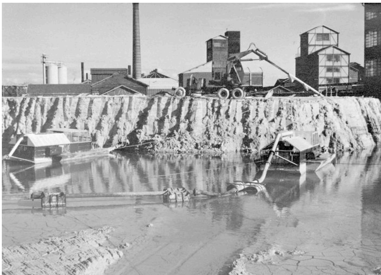
Travaux de terrassement (AP).
