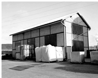
Chaufferie : flanc nord. Phot. Thierry Lefébure IVR22_19926000376X
