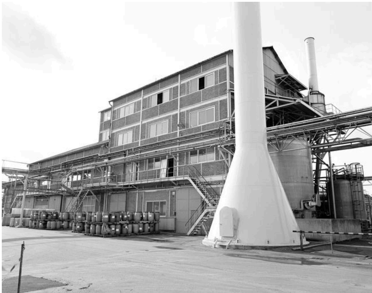
Atelier de fabrication et château d'eau : flanc ouest.
