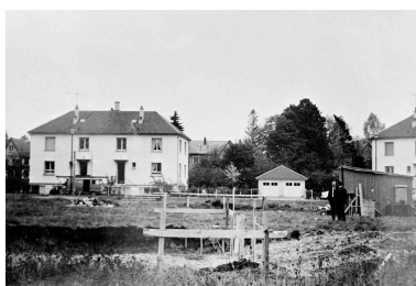
Construction de logements pour les cadres, vers 1959-1964 (AP). Repro. Glotain Patrick IVR22_19936000481XB
