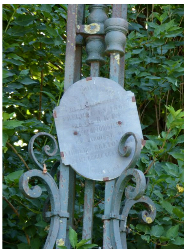
Vue de la plaque en zinc portant les inscriptions. Phot. Isabelle Barbedor IVR32_20208005151NUCA
