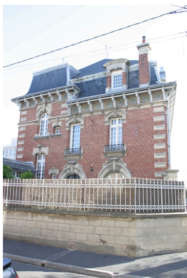
Le logement patronal, vu depuis la rue du Général Legrand-Girarde. Phot. Frédéric Pillet IVR22_20040201083NUCA
