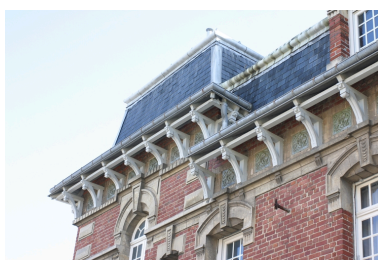
Le logement patronal : détail. Phot. Frédéric Pillet IVR22_20040201084NUCA
