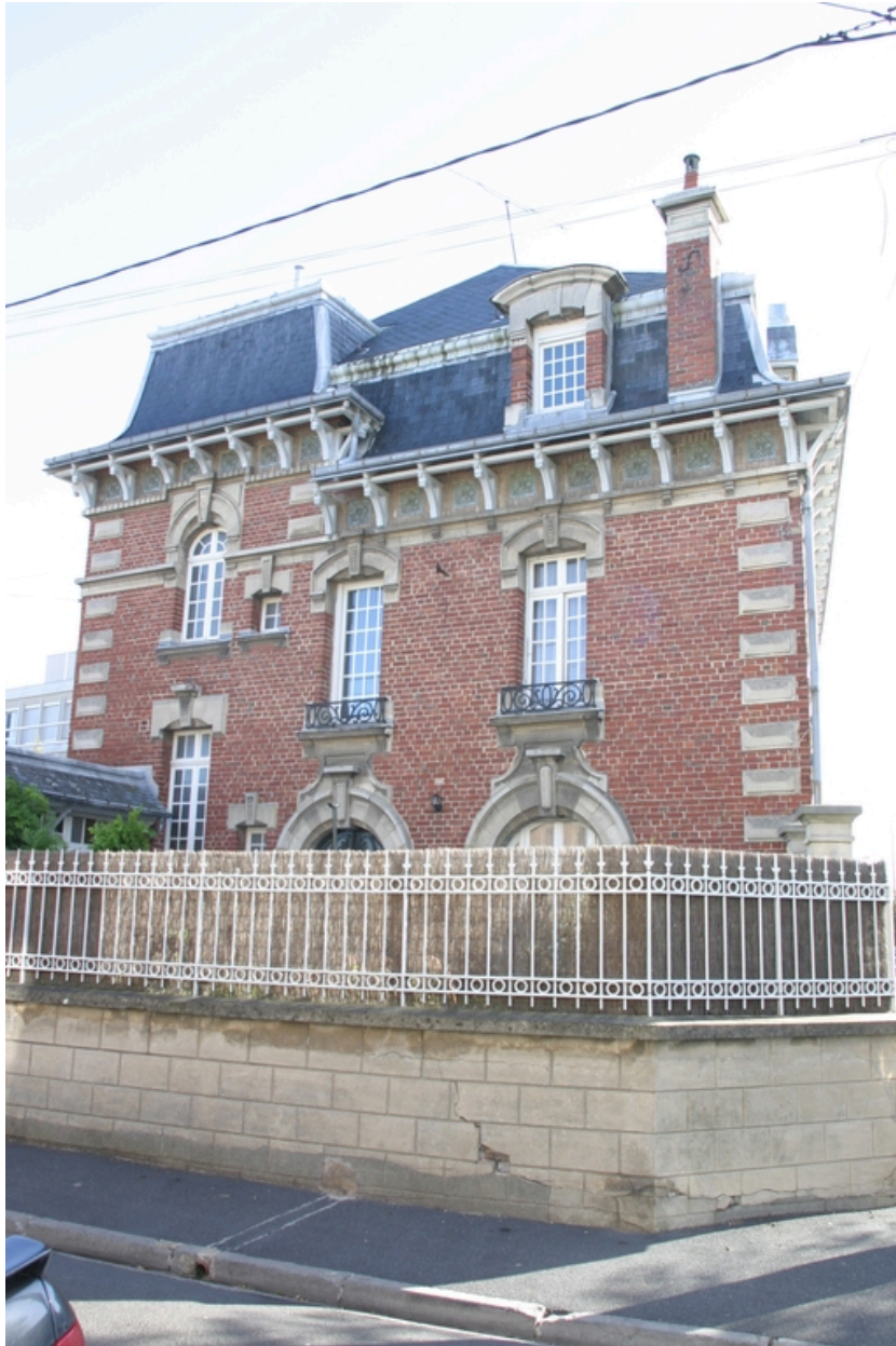
Le logement patronal, vu depuis la rue du Général Legrand-Girarde.
