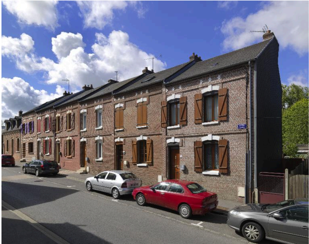
Vue générale depuis le sud.
