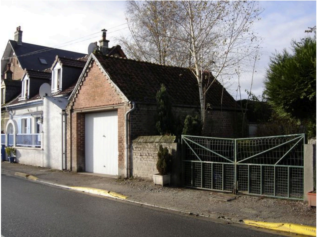
Détail de l'annexe.
