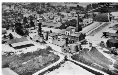
Vue aérienne, après 1949 (AP). Phot. Bertrand Fournier IVR22_20006000113ZB
