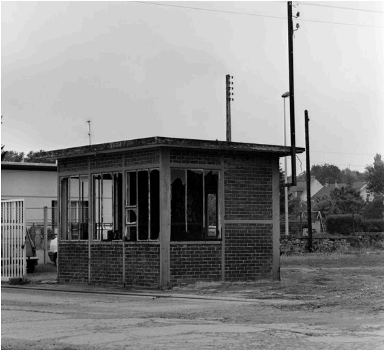
Pont bascule et bureau.
