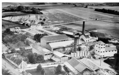
Vue aérienne, après 1949 (AP). Phot. Bertrand Fournier IVR22_20006000112ZB
